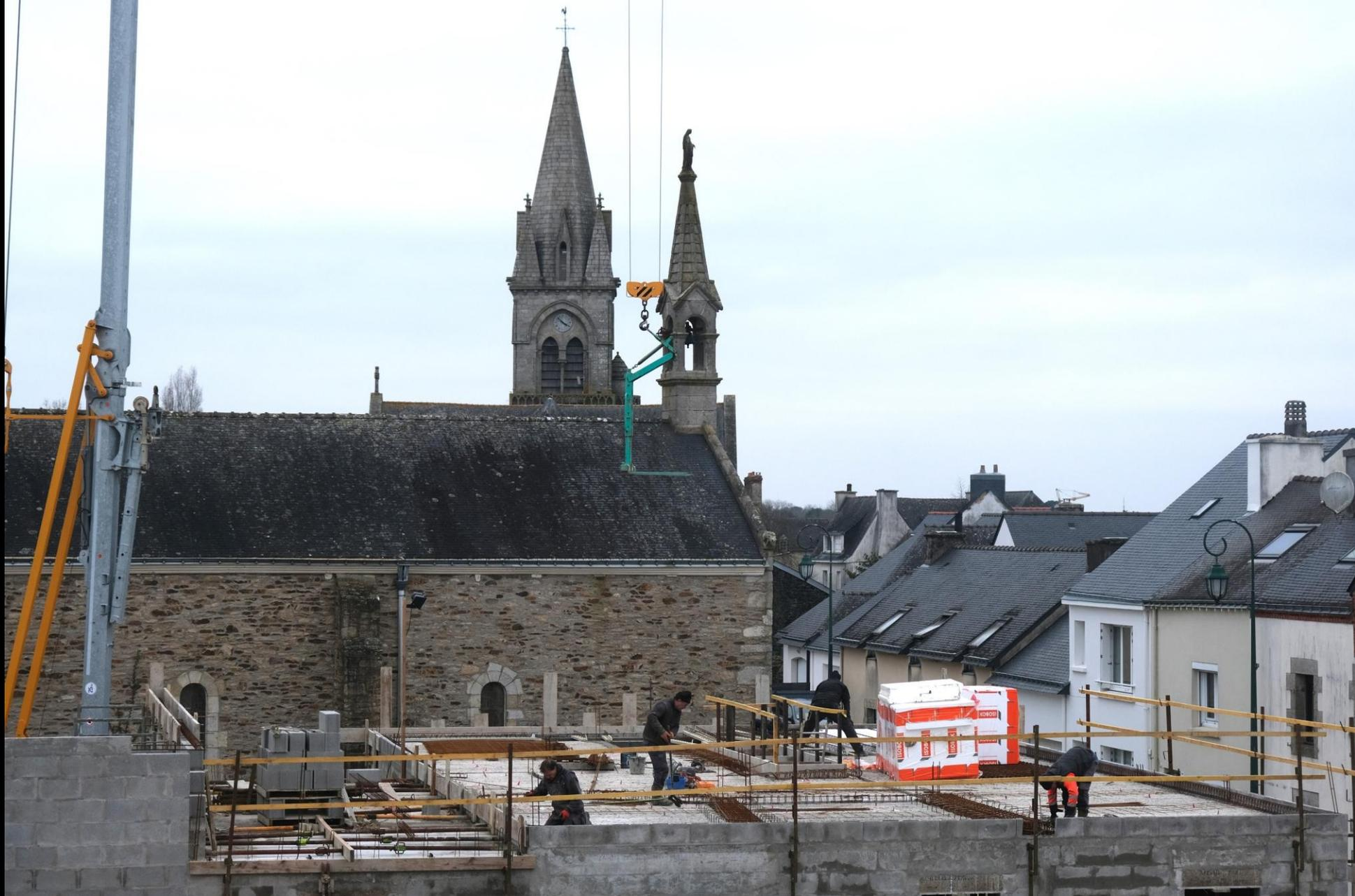
Les prédalles sont posées, les maçons disposent maintenant d'une semaine pour réaliser les travaux préparatoires au coulage de la dalle programmé le 18 décembre.
