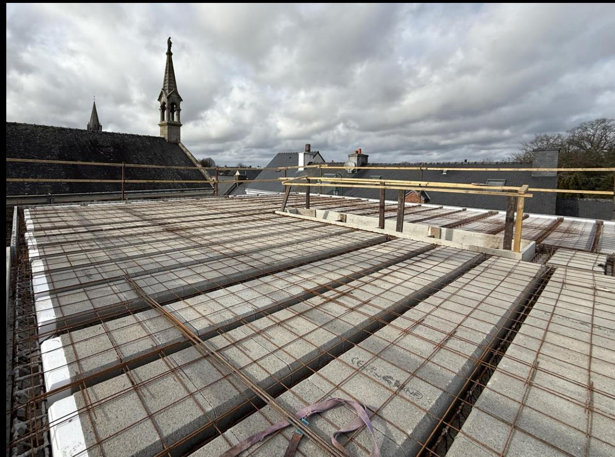
4 février 2025 : sous le plancher, les étais sont en place pour soutenir le poids du béton qui va être coulé dans 2 jours, et sur les poutrelles et hourdis, le ferrailage a été réalisé pour une dalle bien solide.
