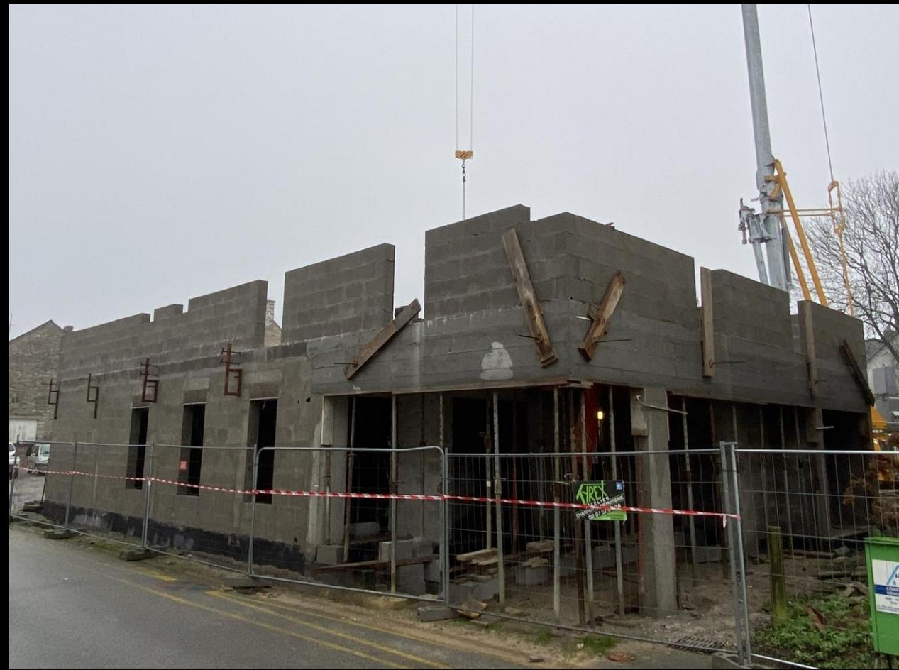
10 janvier 2025 : la première semaine de janvier se termine avec un temps toujours aussi humide. Malgré cela, les maçons s'activent pour monter les parpaings, et les ouvertures de l'étage commencent à apparaître. A l'intérieur, ils préparent le coffrage pour couler prochainement l'escalier en béton.
