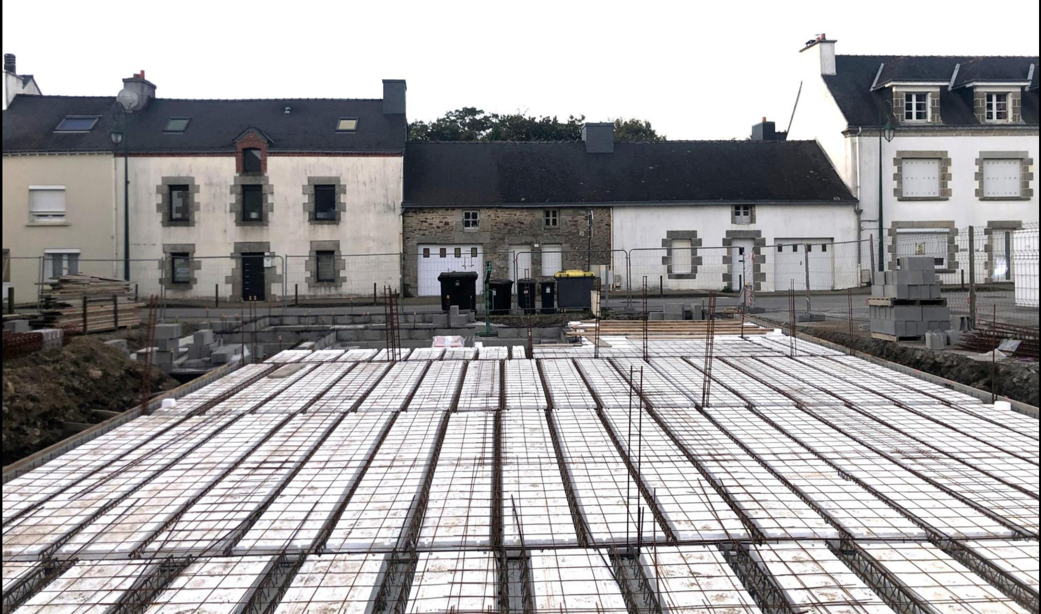
27 septembre 2024 : il faut ferrailer le plancher avant de couler le béton.
