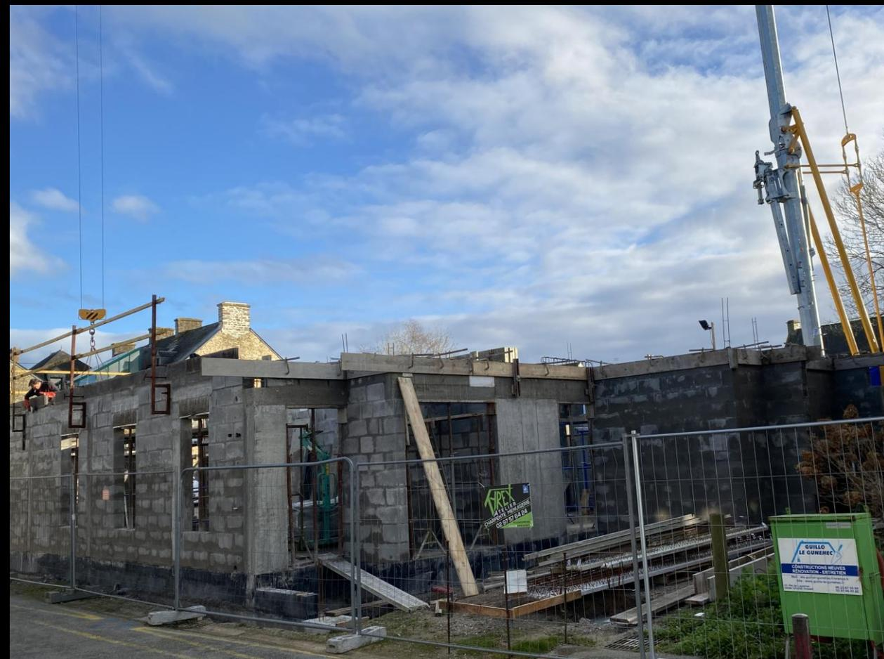
2 décembre 2024 : les maçons mettent en place les planelles avant la pose du plancher dans les prochains jours.
