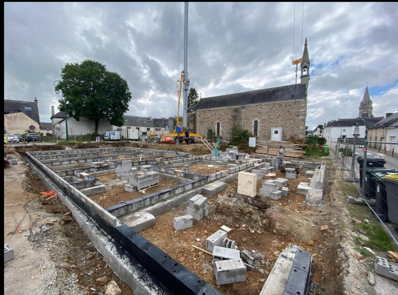
24 septembre 2024 : mise en place des planelles, le plancher va bientôt pouvoir être posé.
