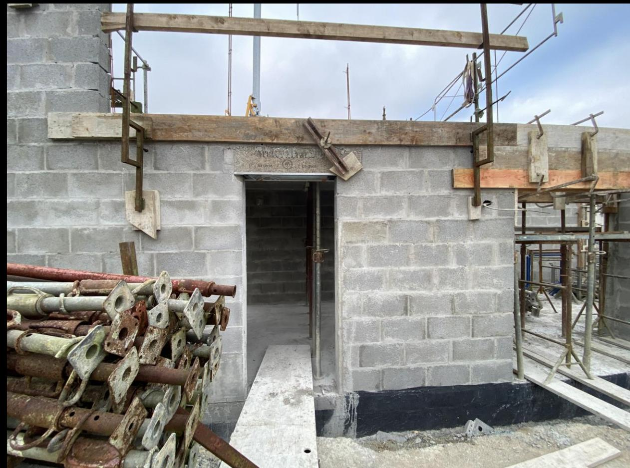
Côté Ouest, 2 rangs de parpaings sont montés au-dessus des poutres, tandis que le plancher est posé au-dessus du futur bureau d'accueil et de la petite salle de réunion.
