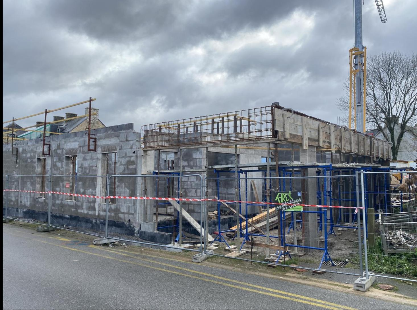
6 décembre 2024 : le pilier étant coulé et décoffré, les maçons peuvent mettre en place le ferrailage et un nouveau coffrage pour les prochaines poutres qui soutiendront le plancher haut RDC.
