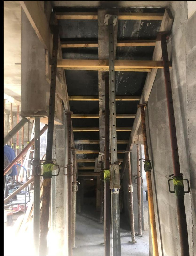
Le coffrage de l'escalier est bientôt terminé. Les marches en béton pourront être coulées sans tarder.
