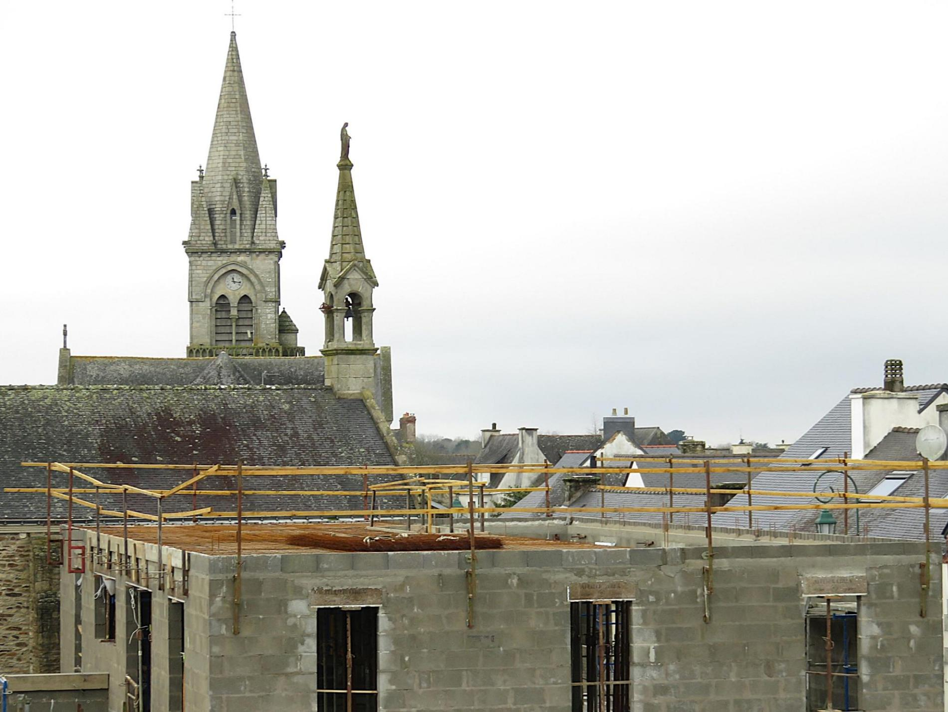
31 janvier 2025 : après la pose des poutrelles et des hourdis, et avant le coulage du béton, les maçons ont réalisé le ferrailage du plancher.
