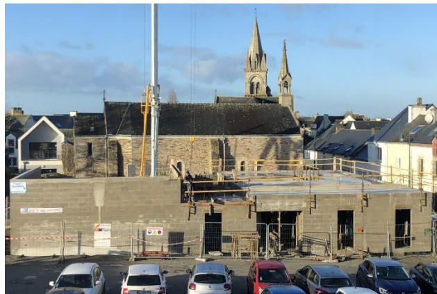
18 décembre 2024 : la totalité du plancher haut est coulée, l'élévation du rez-de-chaussée est terminée.
