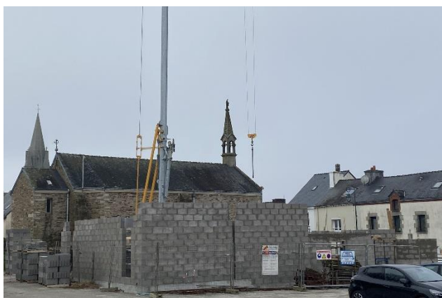
8 novembre 2024 : les murs de la grande salle de réunion atteignent bientôt leur niveau maximal.
