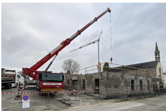
11 décembre 2024 : une grande grue mobile permet aux maçons de poser les prédalles pour le plancher.
