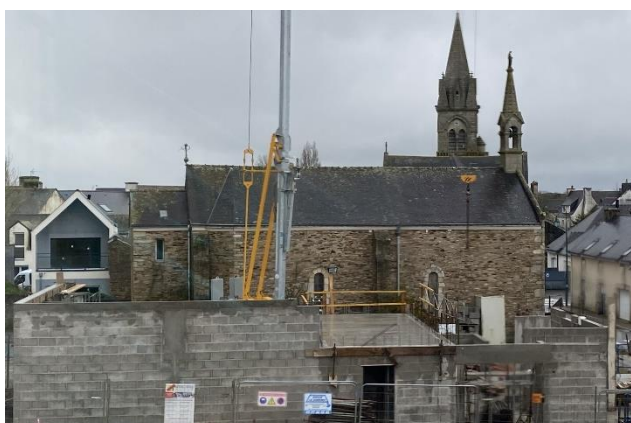
18 novembre 2024 : la dalle est coulée au-dessus du bureau d'accueil et de la petite salle de réunion.
