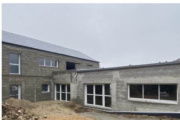
15 avril 2025 : une nouvelle étape est franchie avec la pose des fenêtres et portes-fenêtres.
