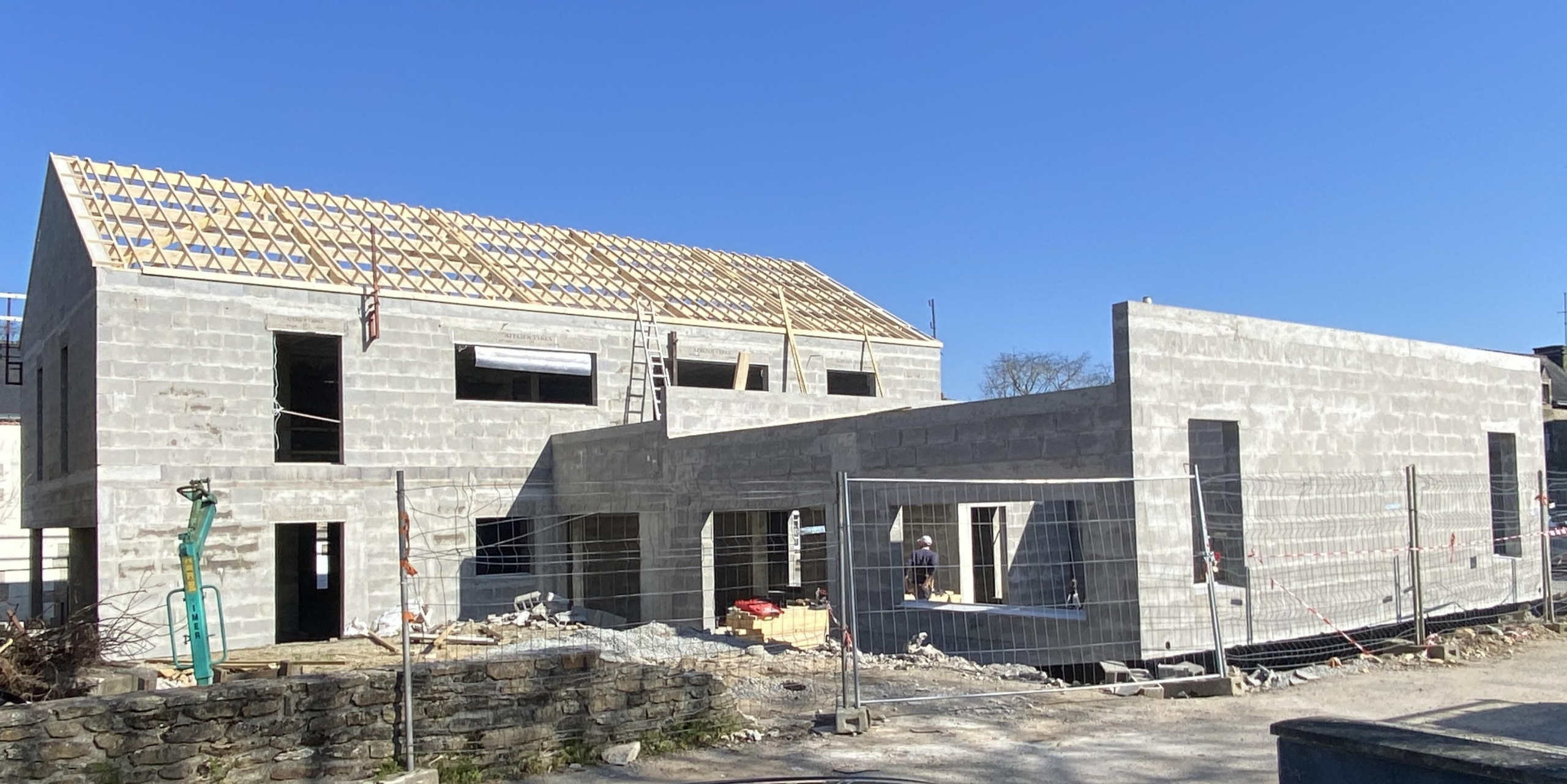
5 mars 2025 : la charpente est quasiment terminée sur le grand bâtiment. Les charpentiers vont pouvoir s'atteler au montage de la deuxième charpente.
