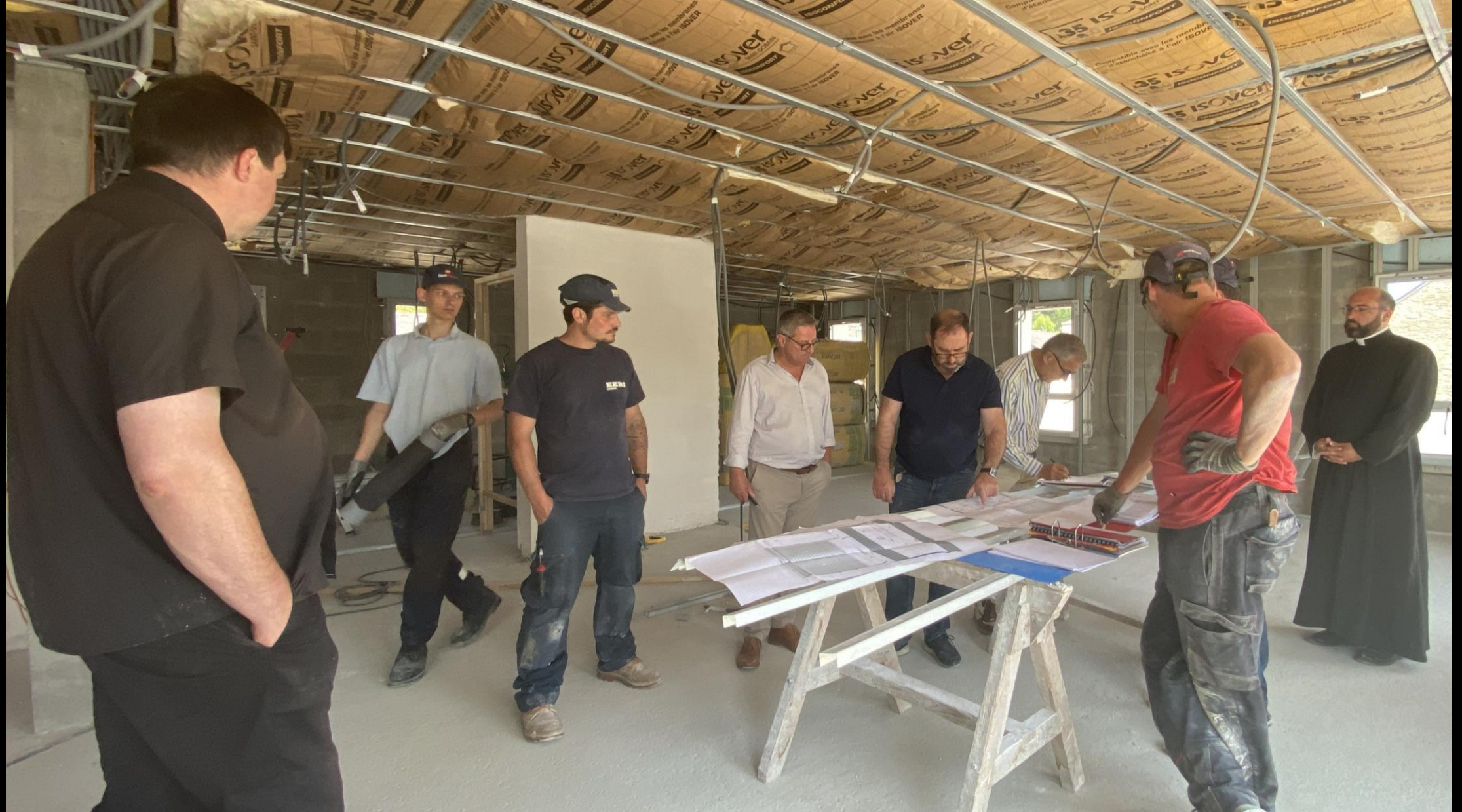
Sous le regard attentif du père Jean et du père Louis-Marie, les acteurs du chantier vérifient chaque détail pour une réalisation conforme au projet et aux normes diverses qui doivent être strictement respectées.
