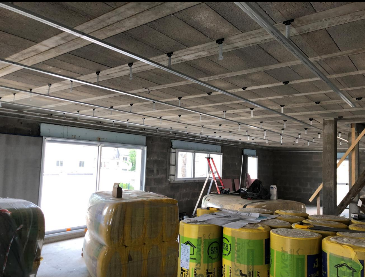
22 mai 2025 : les rails métalliques sont fixés aux plafonds et aux murs. Ils serviront de support pour fixer le placo après la mise en place de l'isolant.
