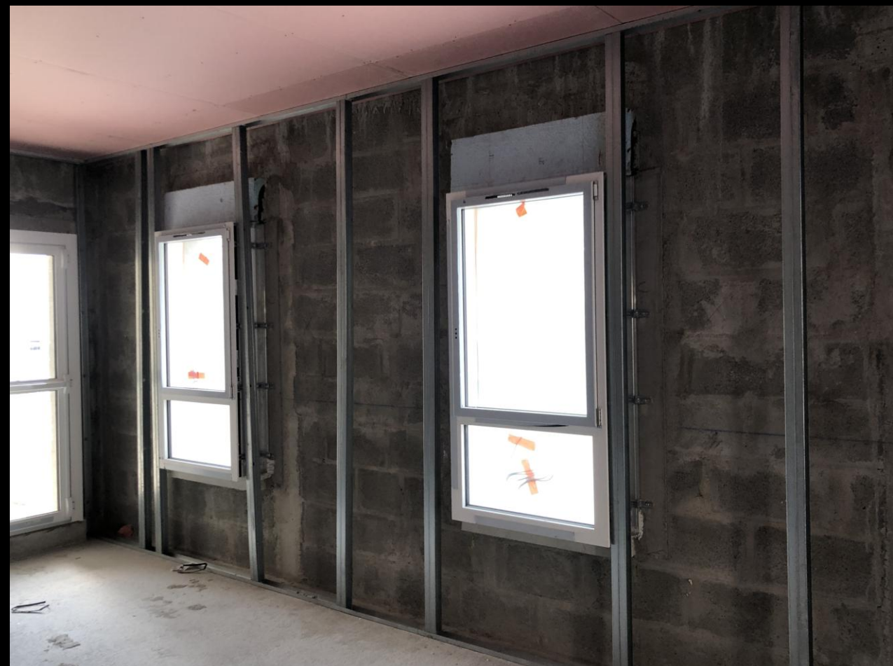
22 mai 2025 : les rails métalliques sont fixés aux plafonds et aux murs. Ils serviront de support pour fixer le placo après la mise en place de l'isolant.
