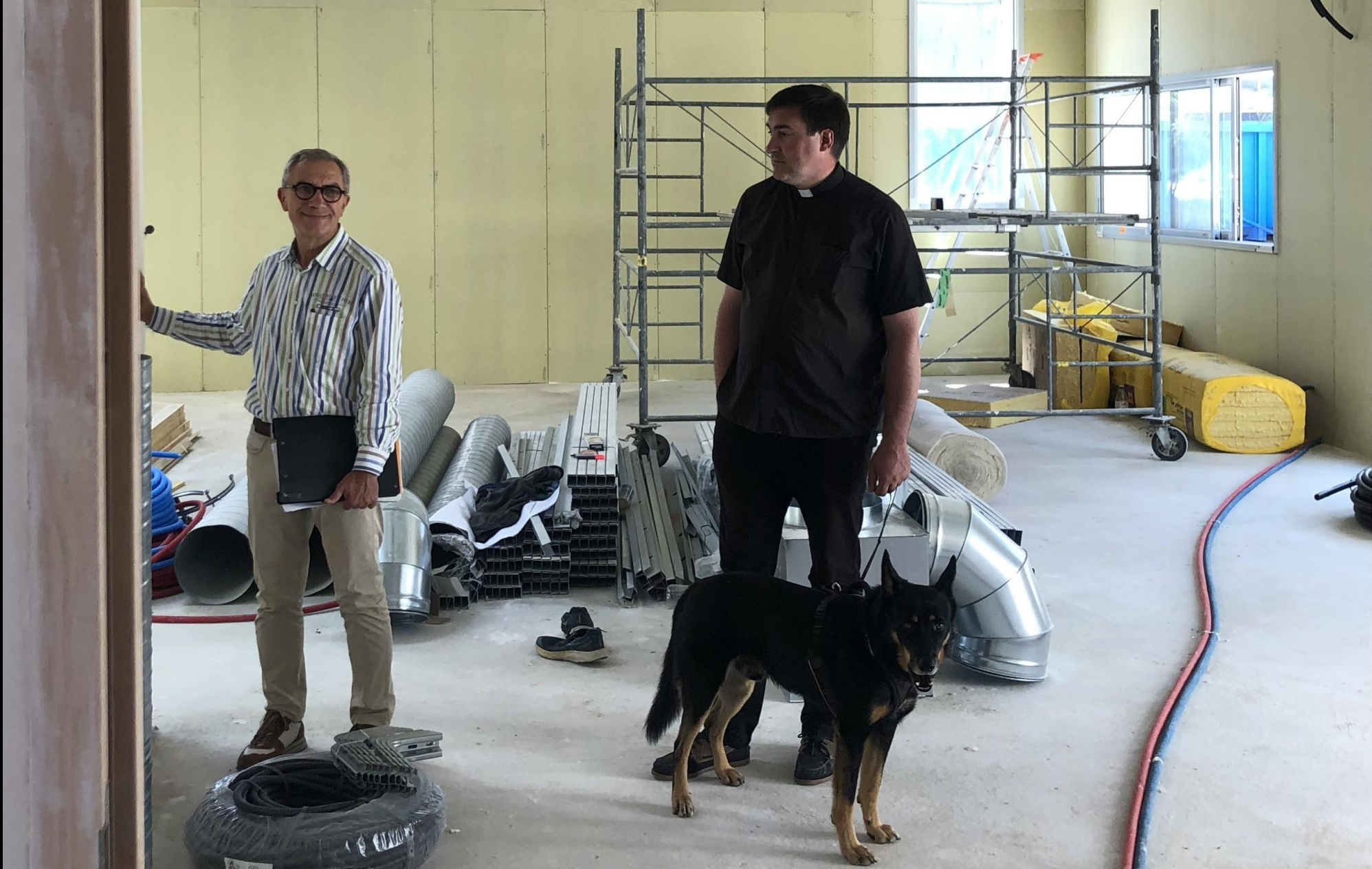
Guénaël Le Port, architecte, et Père Jean, curé de la paroisse sont satisfaits de l'avancée du chantier. Mais Rafale n'a pas encore exprimé son avis !
