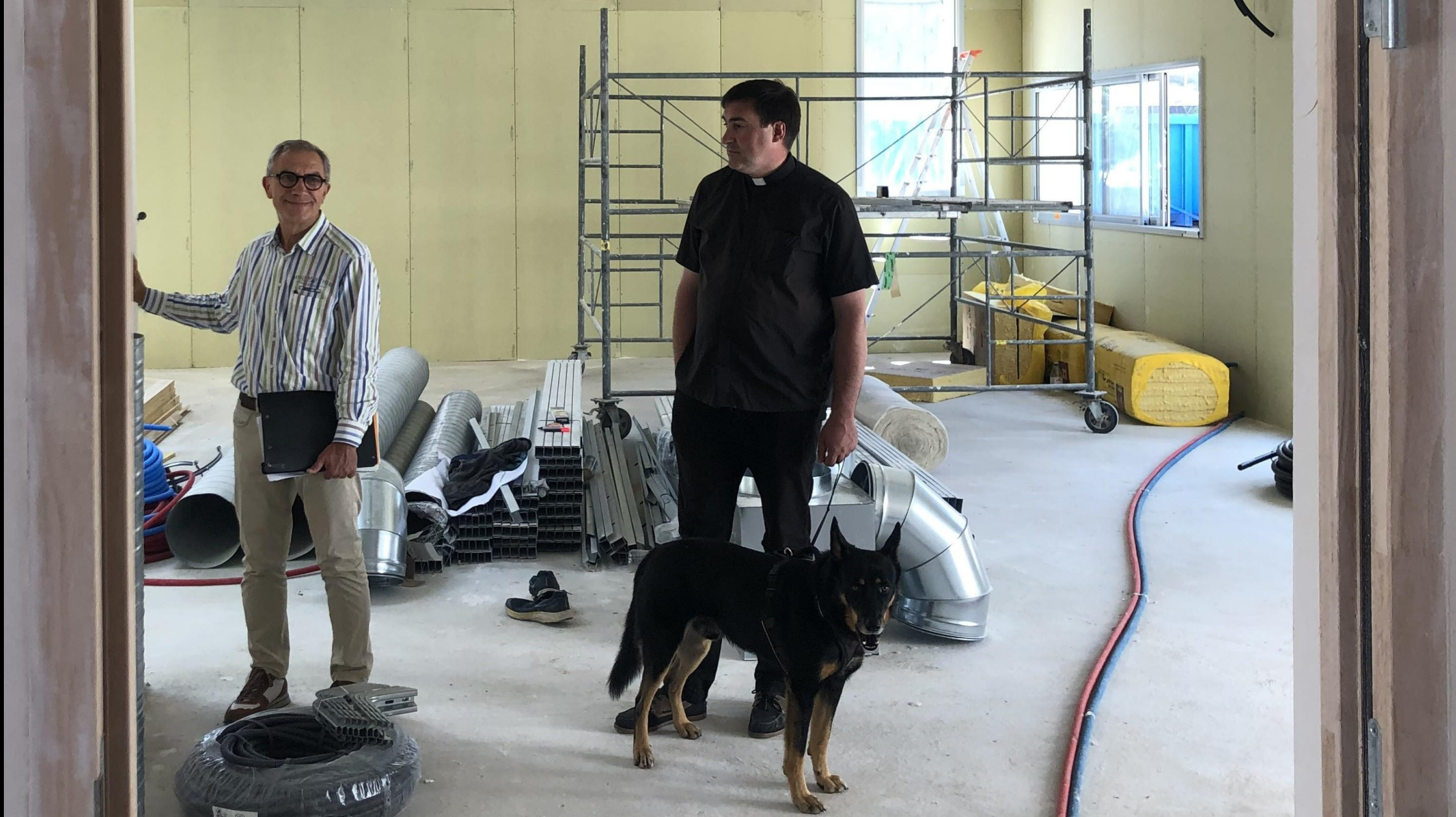
Guénaël Le Port, architecte, et Père Jean, curé de la paroisse sont satisfaits de l'avancée du chantier. Mais Rafale n'a pas encore exprimé son avis !
