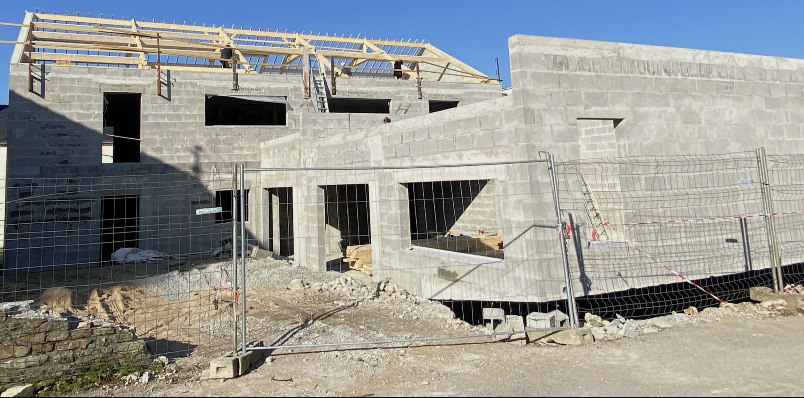
3 mars 2025 : tous les chevrons étant désormais posés côté Nord, les charpentiers mettent en place les pannes sur le versant Sud.
