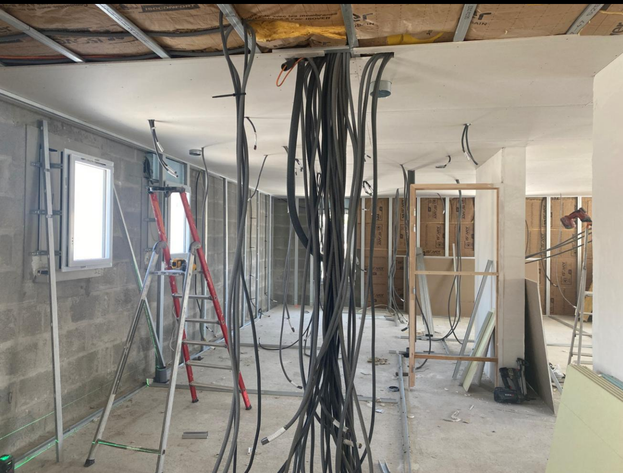
A l'étage, la pose du placo au plafond avance rapidement.
