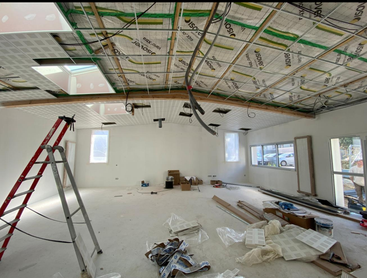
Le chantier avance aussi pour les poseurs des plafonds suspendus (ici dans la grande salle de réunion).
