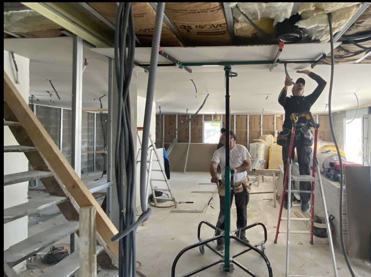
A l'étage, la pose du placo au plafond avance rapidement.
