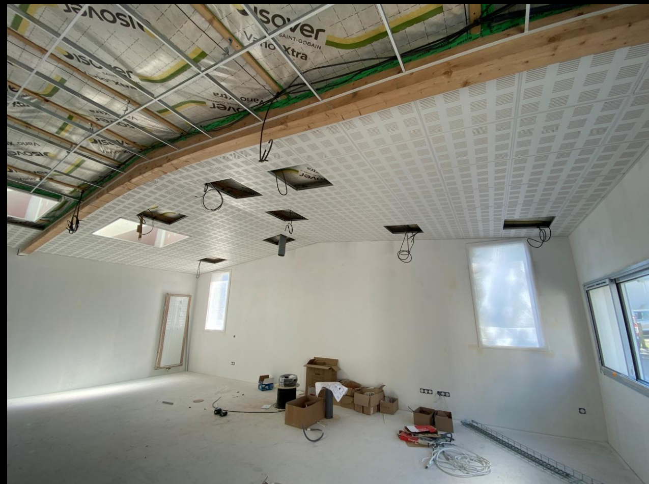
Le chantier avance aussi pour les poseurs des plafonds suspendus (ici dans la grande salle de réunion).
