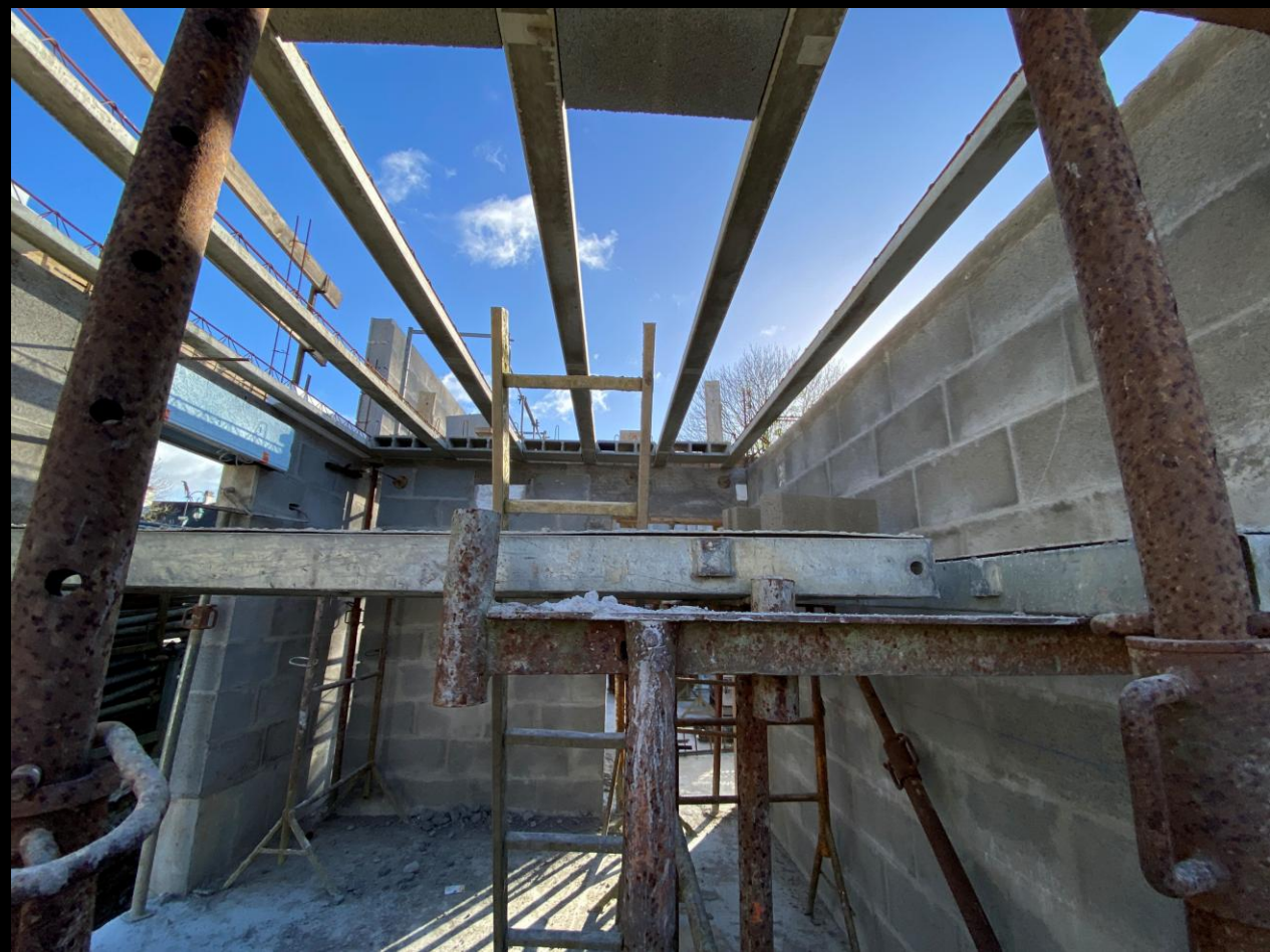
12 novembre 2024 : les maçons ont commencé à positionner les poutrelles pour une partie du plancher haut.
