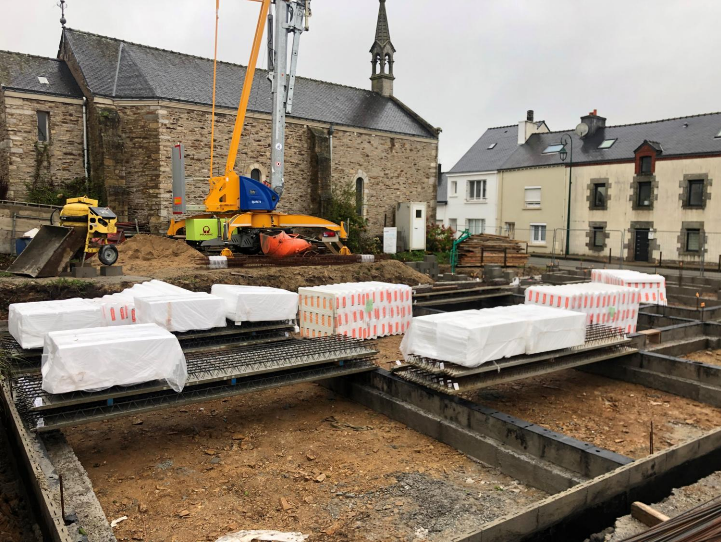
25 septembre 2024 : des poutrelles et hourdis sont livrés sur le chantier, les maçons commencent la pose du plancher.
