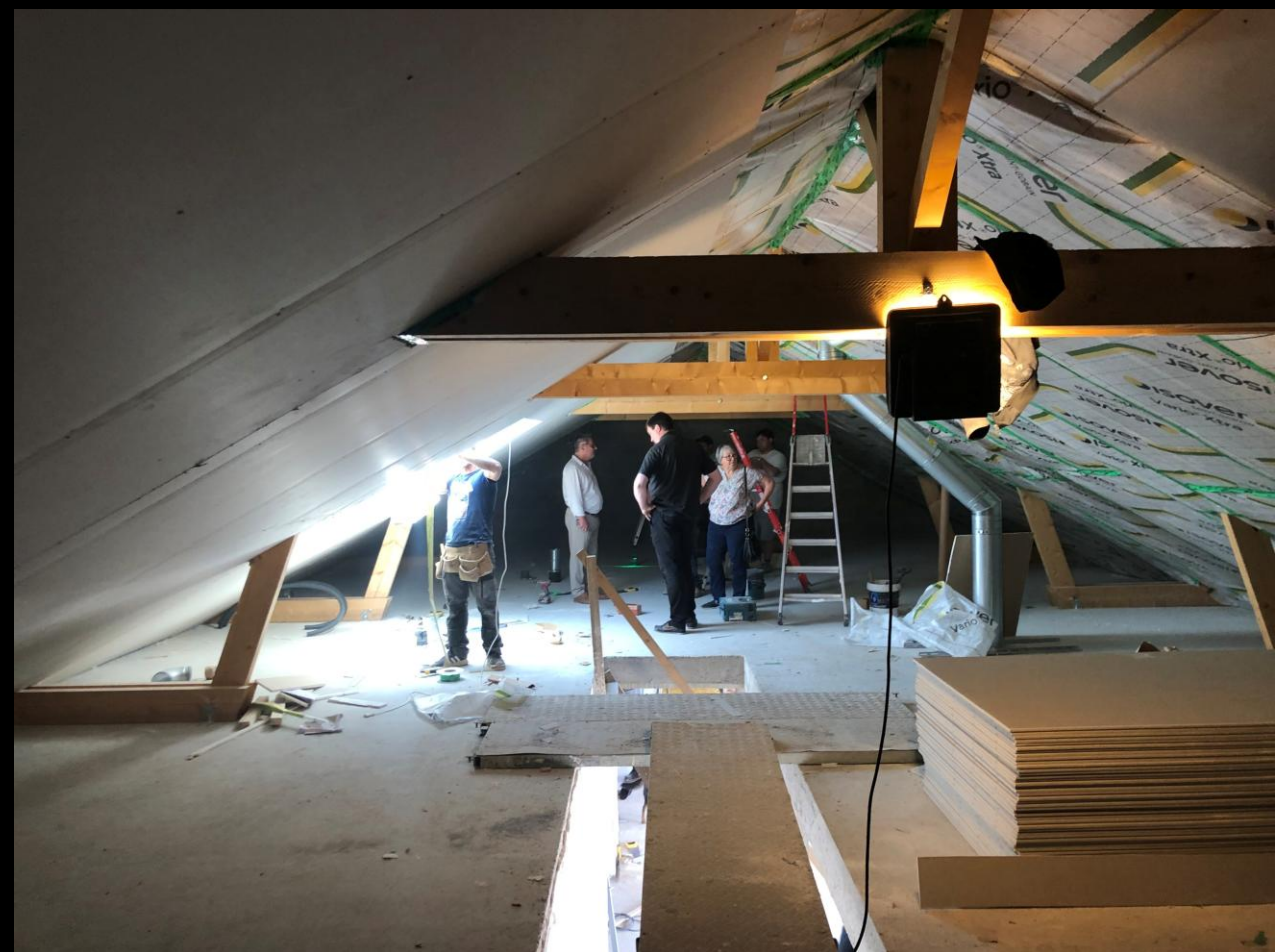
Les travaux sont presque terminés dans le grenier avec l'isolation et le placo.
