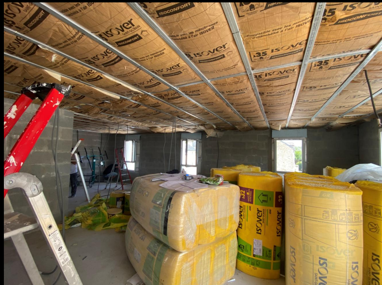
Les travaux avancent également à l'étage, avec le câblage électrique, la plomberie, l'isolation.
