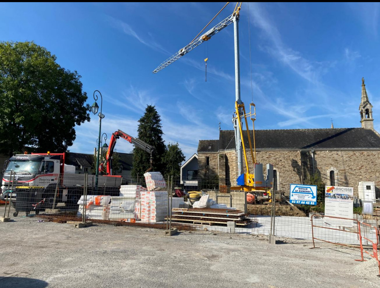
4 octobre 2024 : des hourdis et de la ferraille sont livrés pour réaliser la dernière partie du plancher.
