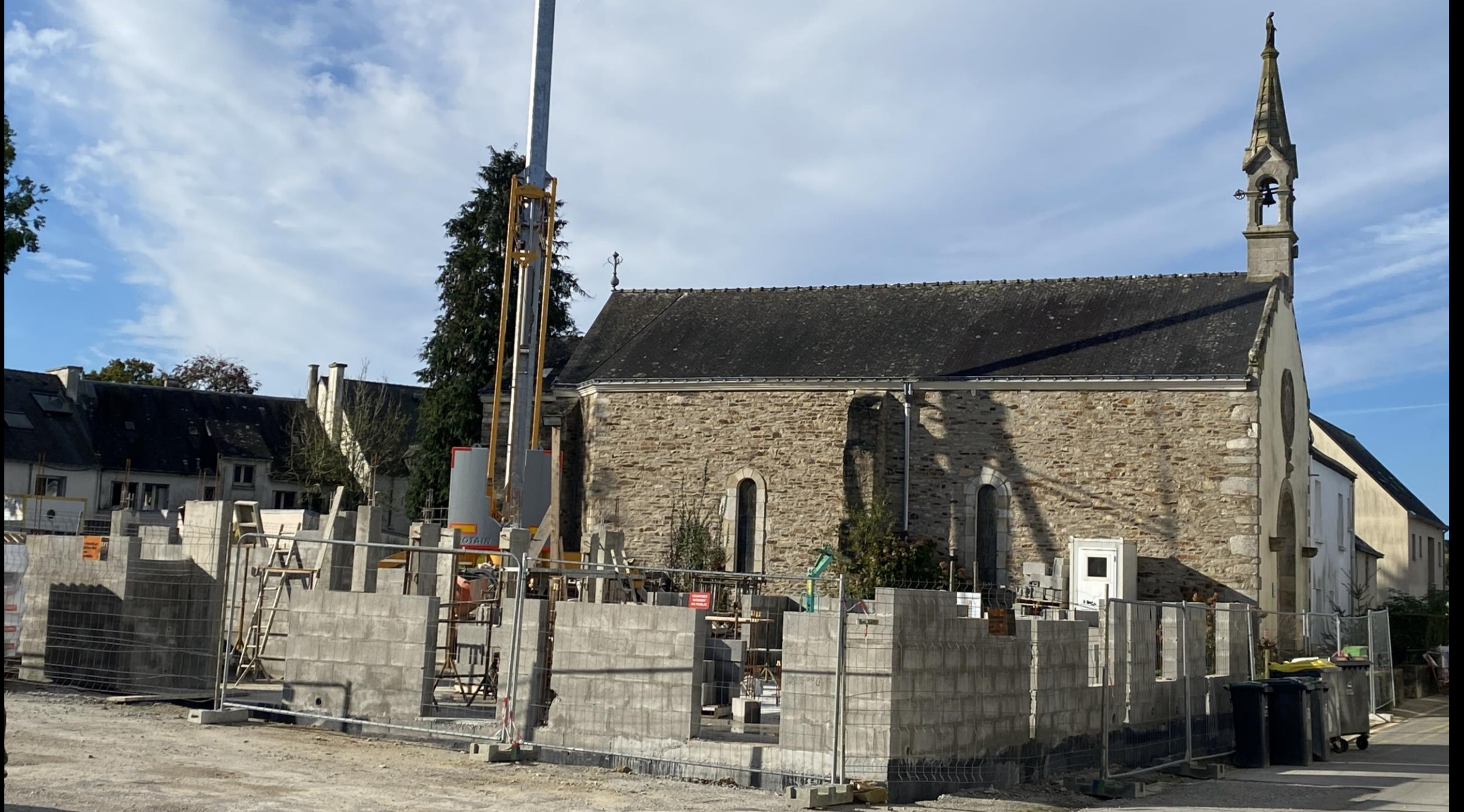
25 octobre 2024 : la semaine se termine, 5 rangs de parpaings sont posés pour les murs extérieurs.
