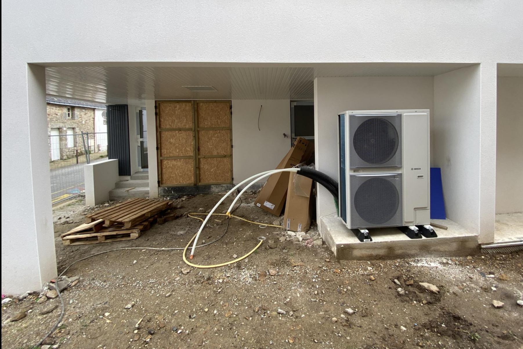
A l'extérieur, le bloc de pompe à chaleur a été installé par le chauffagiste.
