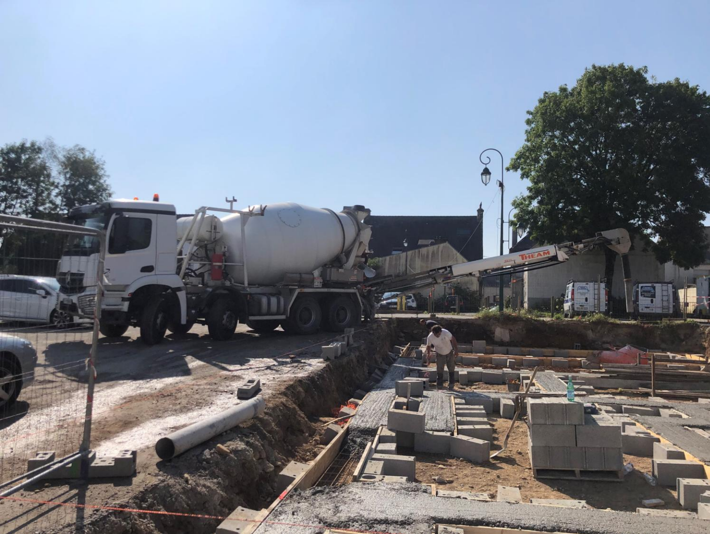
19 septembre 2024 : les maçons coulent les fondations sur lesquelles s'élèvera la maison interparoissiale.
