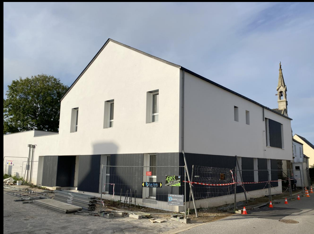
7 octobre : la pose du bardage extérieur se poursuit sur le pignon Ouest et la façade Nord.
