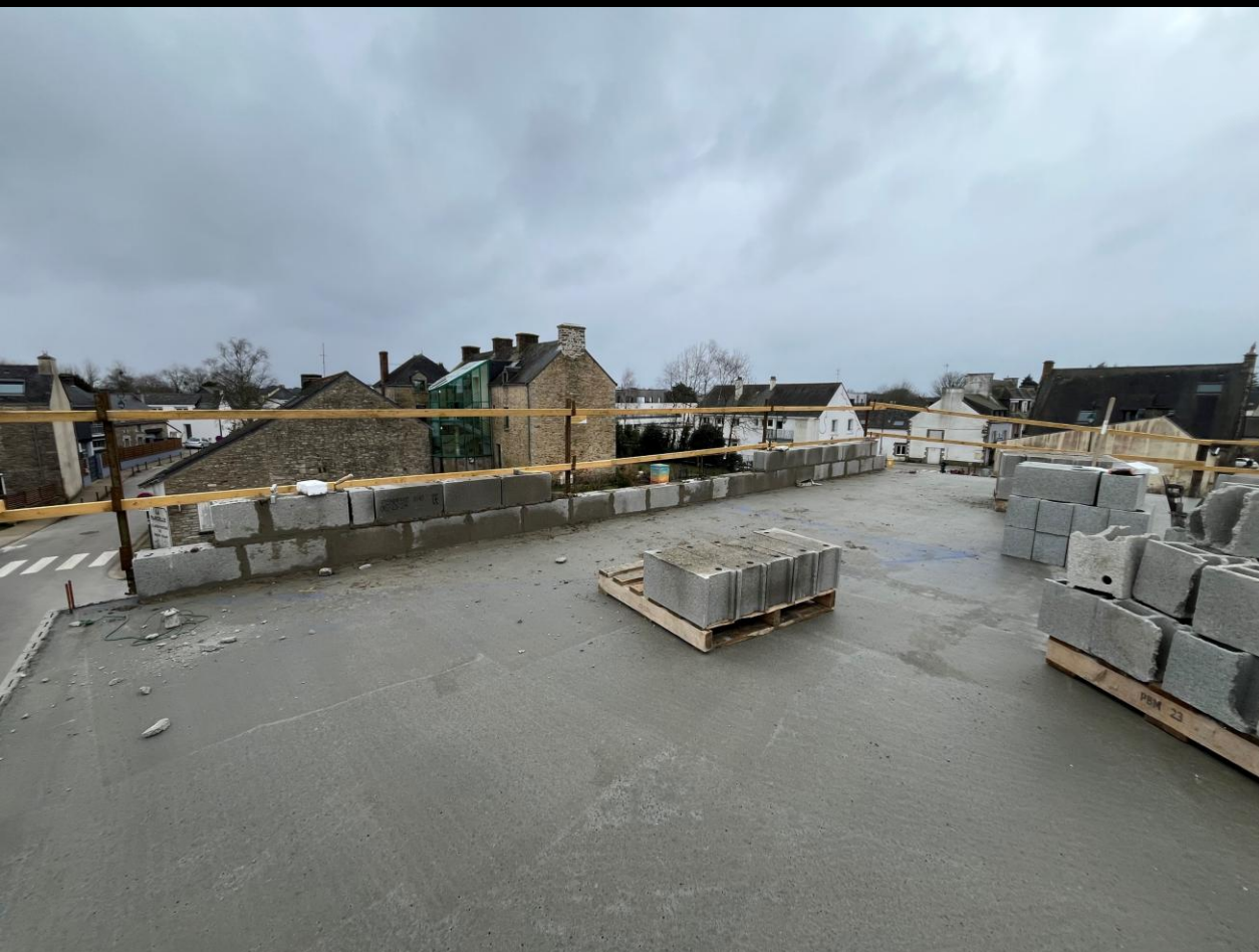
7 février 2025 : la dalle étant coulée, les maçons s'attaquent maintenant à la dernière partie du travail les concernant : le montage des pointes des pignons.
