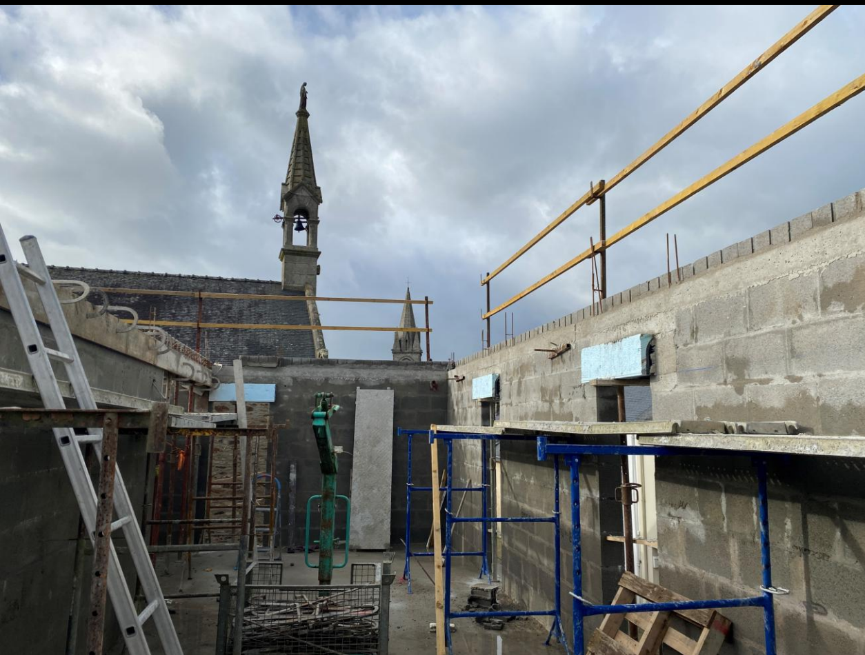
28 janvier 2025 : le chaînage est coulé, les planelles sont posées, les poutrelles et hourdis vont maintenant pouvoir être mis en place.
