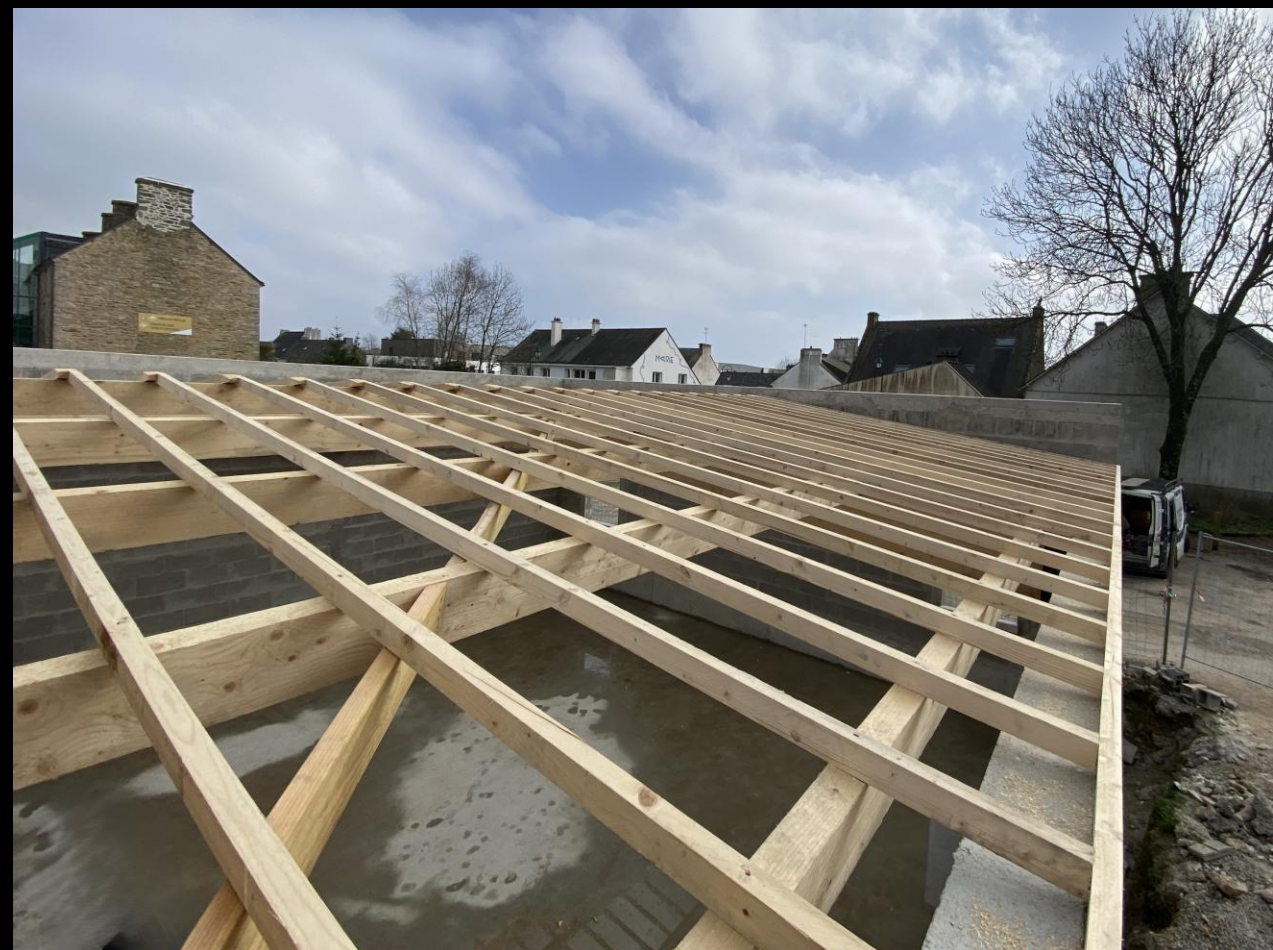
7 mars 2025 : la charpente de la grande salle de réunion est terminée. Le couvreur va pouvoir intervenir dans une quinzaine jours pour la pose de la toiture.
