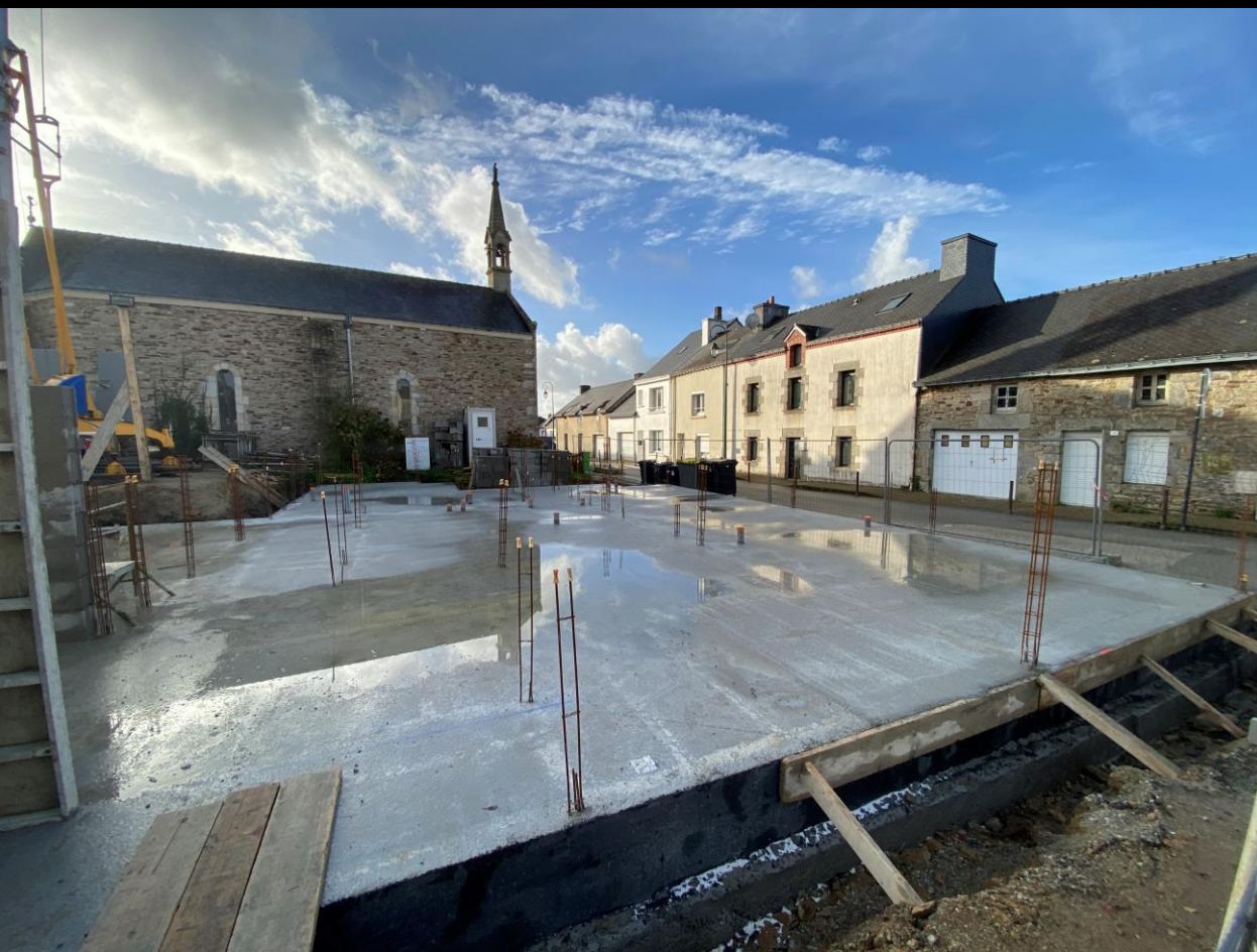
17 octobre 2024 : la dalle est entièrement coulée, ainsi que la base des murs extérieurs en banché.
