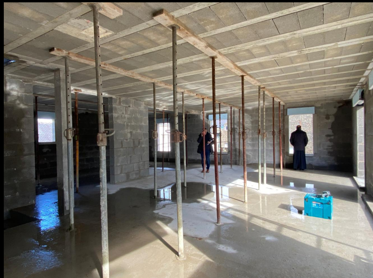
A l'étage, quelques étais soutiennent encore le plancher en béton.
