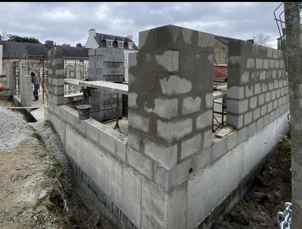
29 octobre 2024 : l'élévation des murs extérieurs se poursuit, tandis que des premiers murs intérieurs et des poteaux commencent à dessiner les futures pièces du bâtiment.
