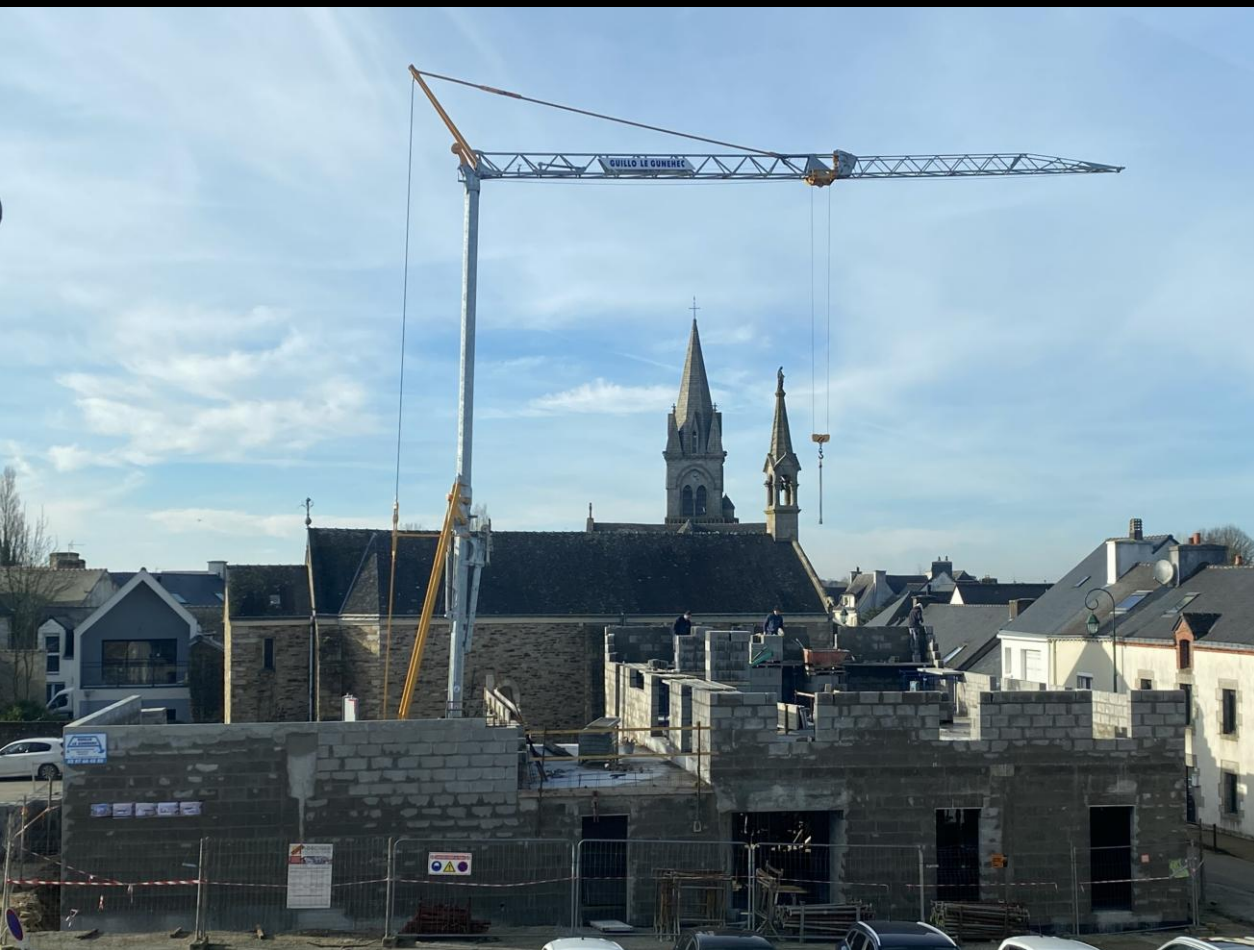
14 janvier 2025 : le soleil est de retour, la météo est à nouveau favorable pour le travail des maçons. Côté Est, les murs s'élèvent et arrivent maintenant au niveau de la gouttière de la chapelle.
