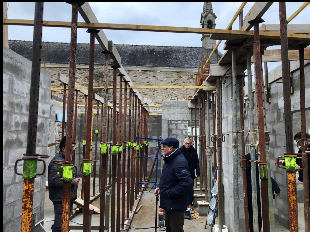
A l'intérieur, les étais sont en place avant la pose imminente du plancher.
