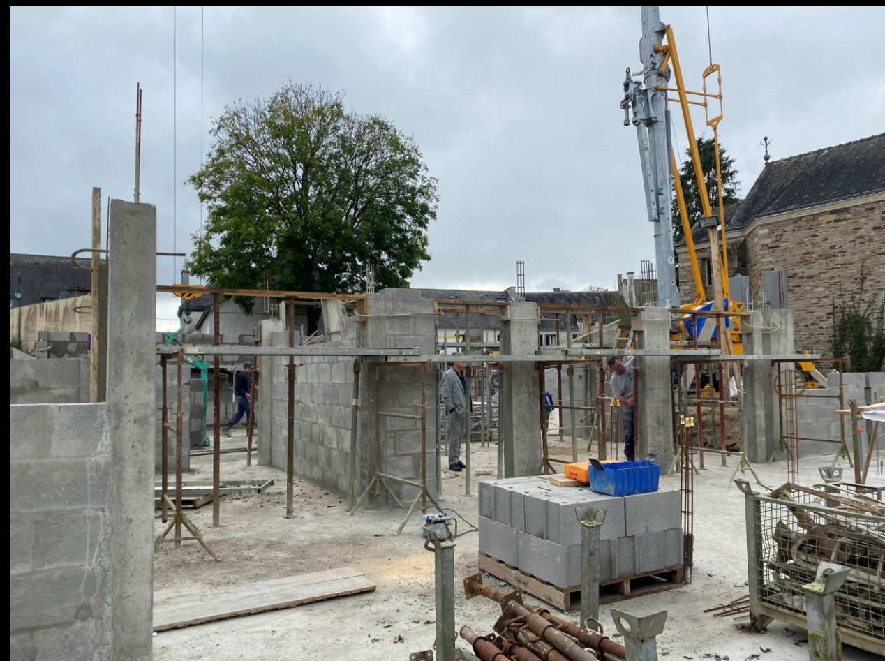
29 octobre 2024 : l'élévation des murs extérieurs se poursuit, tandis que des premiers murs intérieurs et des poteaux commencent à dessiner les futures pièces du bâtiment.
