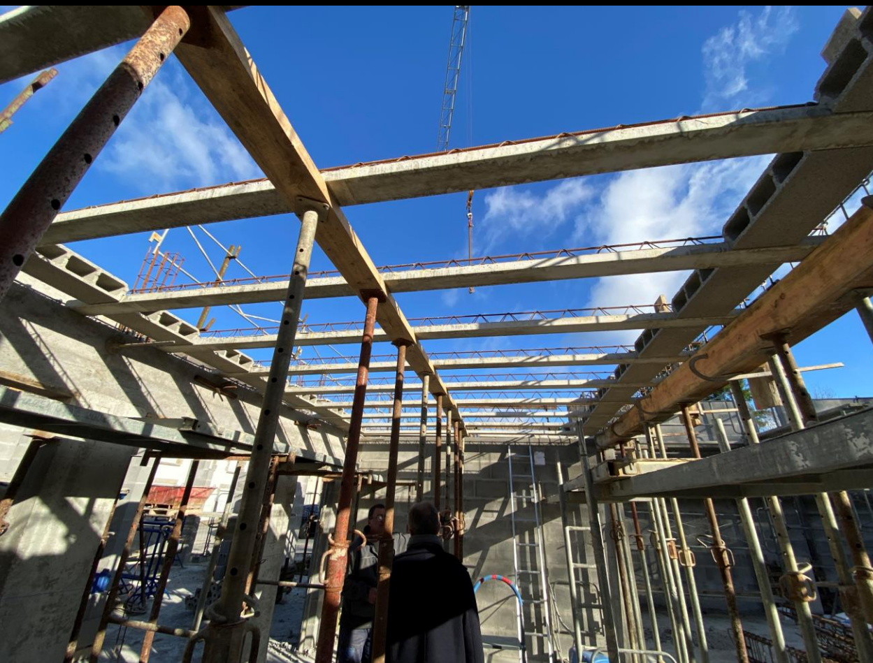
12 novembre 2024 : les maçons ont commencé à positionner les poutrelles pour une partie du plancher haut.
