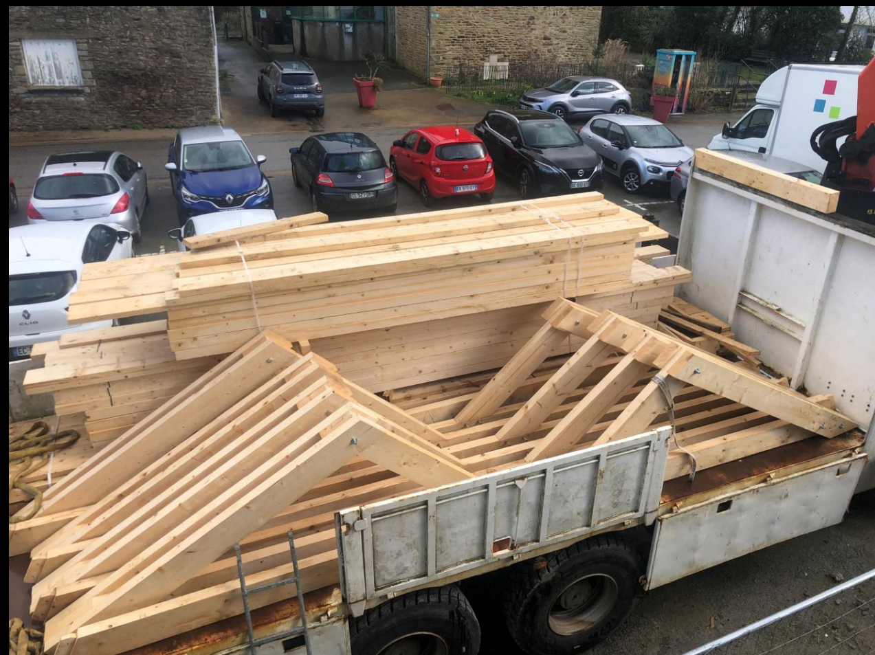
25 février 2025 : les éléments de charpente sont livrés sur le chantier.
