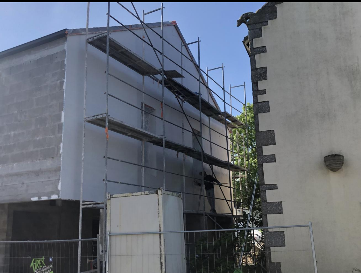
14 mai 2025 : l'enduit réalisé sur 2 premières façades donne un nouvel aspect au bâtiment.
