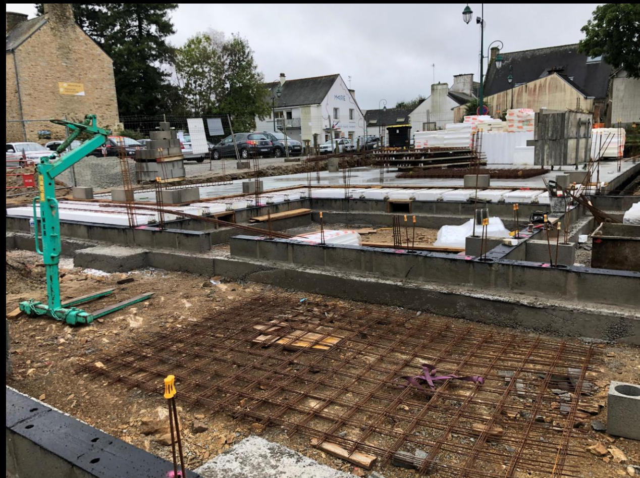
4 octobre 2024 : des hourdis et de la ferraille sont livrés pour réaliser la dernière partie du plancher.
