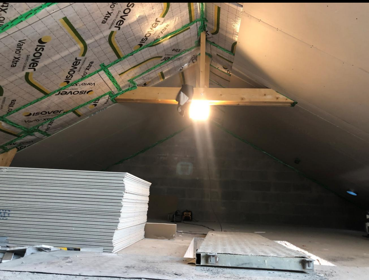
Les travaux sont presque terminés dans le grenier avec l'isolation et le placo.
