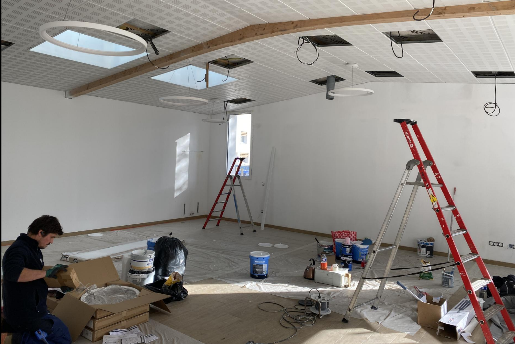
27 octobre : dans la grande salle, l'électricien est concentré pour l'installation de l'éclairage suspendu au plafond.
