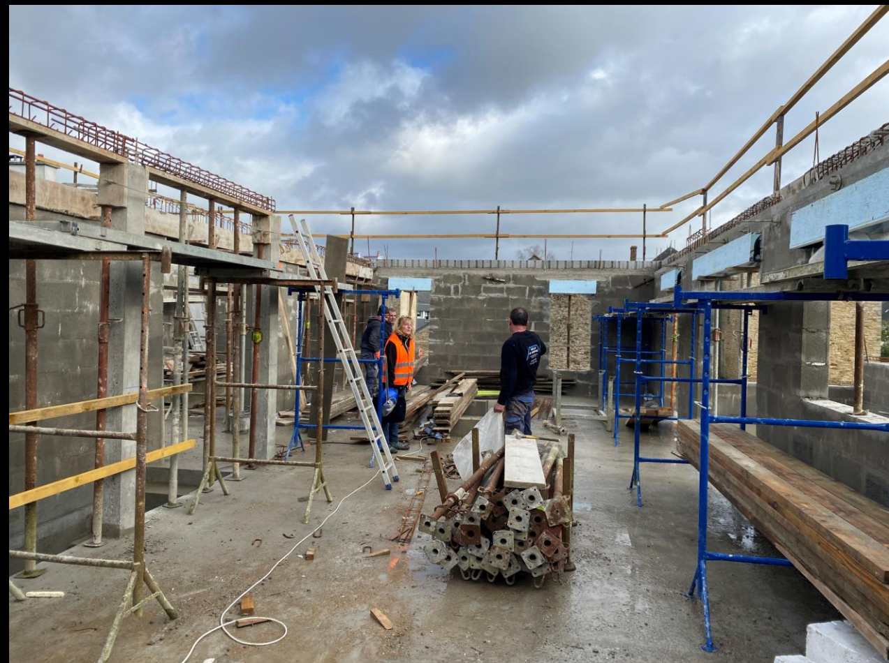
28 janvier 2025 : le chaînage est coulé, les planelles sont posées, les poutrelles et hourdis vont maintenant pouvoir être mis en place.
