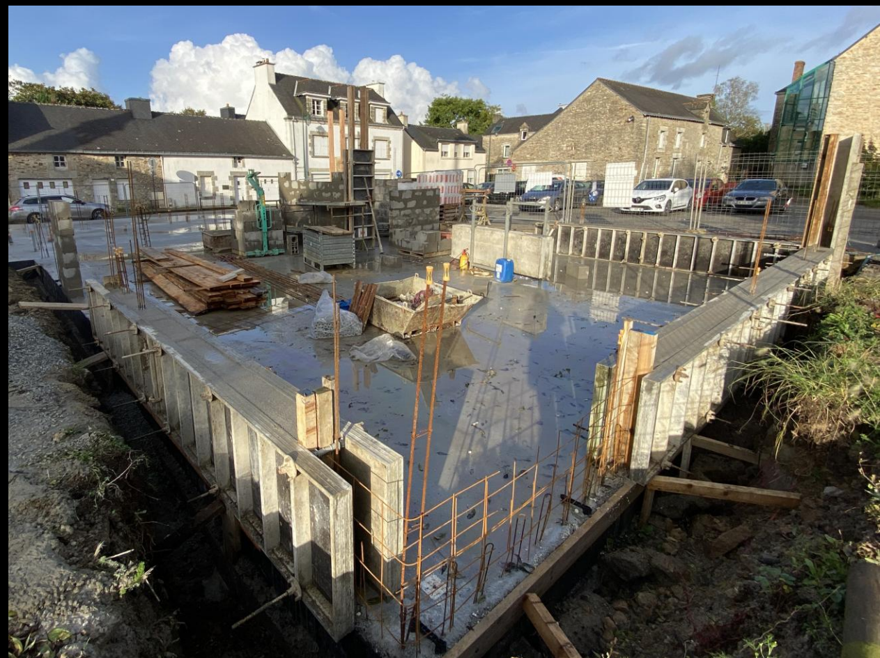
17 octobre 2024 : la dalle est entièrement coulée, ainsi que la base des murs extérieurs en banché.
