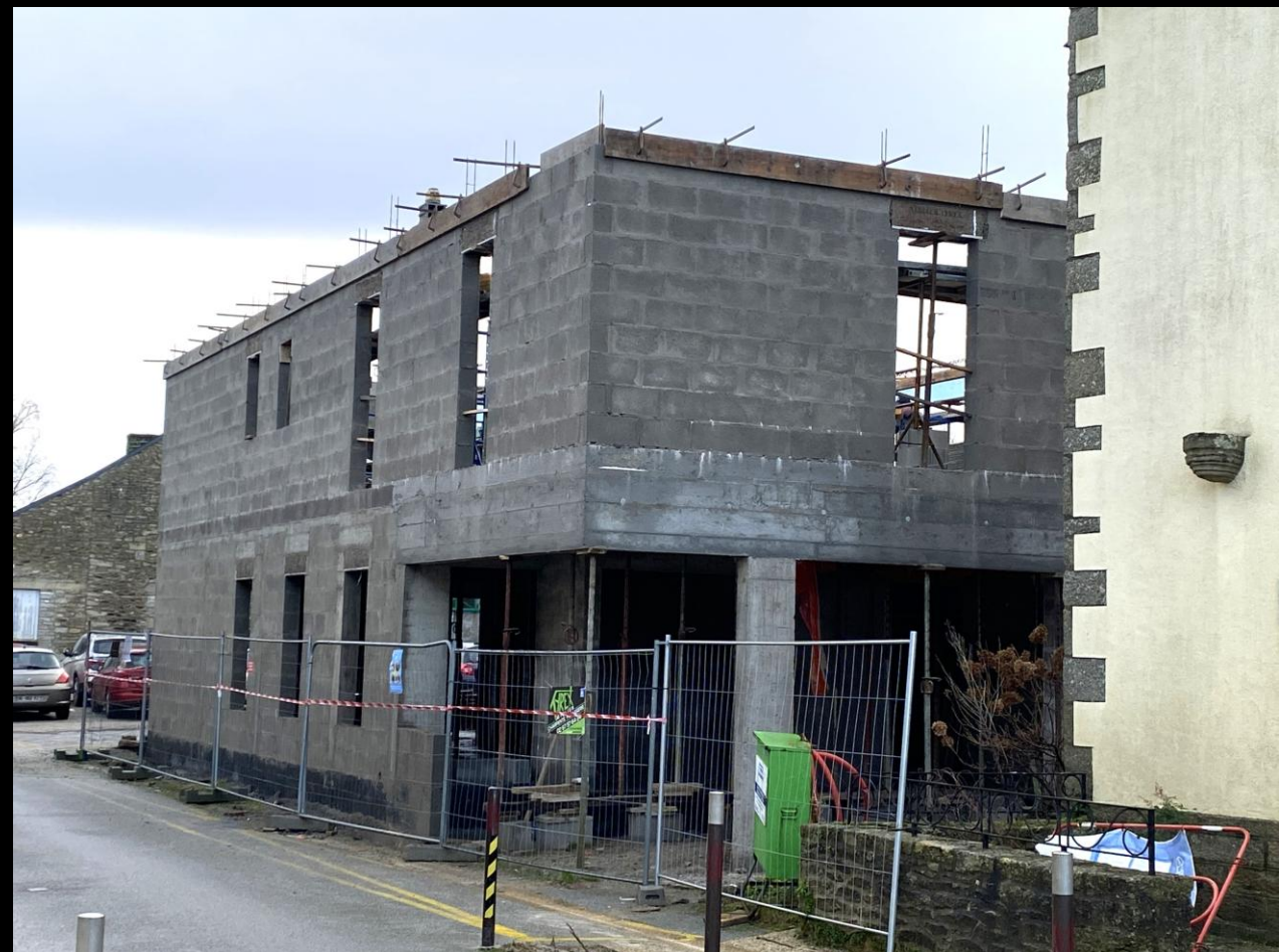
23 janvier 2025 : les maçons ont coffré le sommet des murs du 1 er étage.
