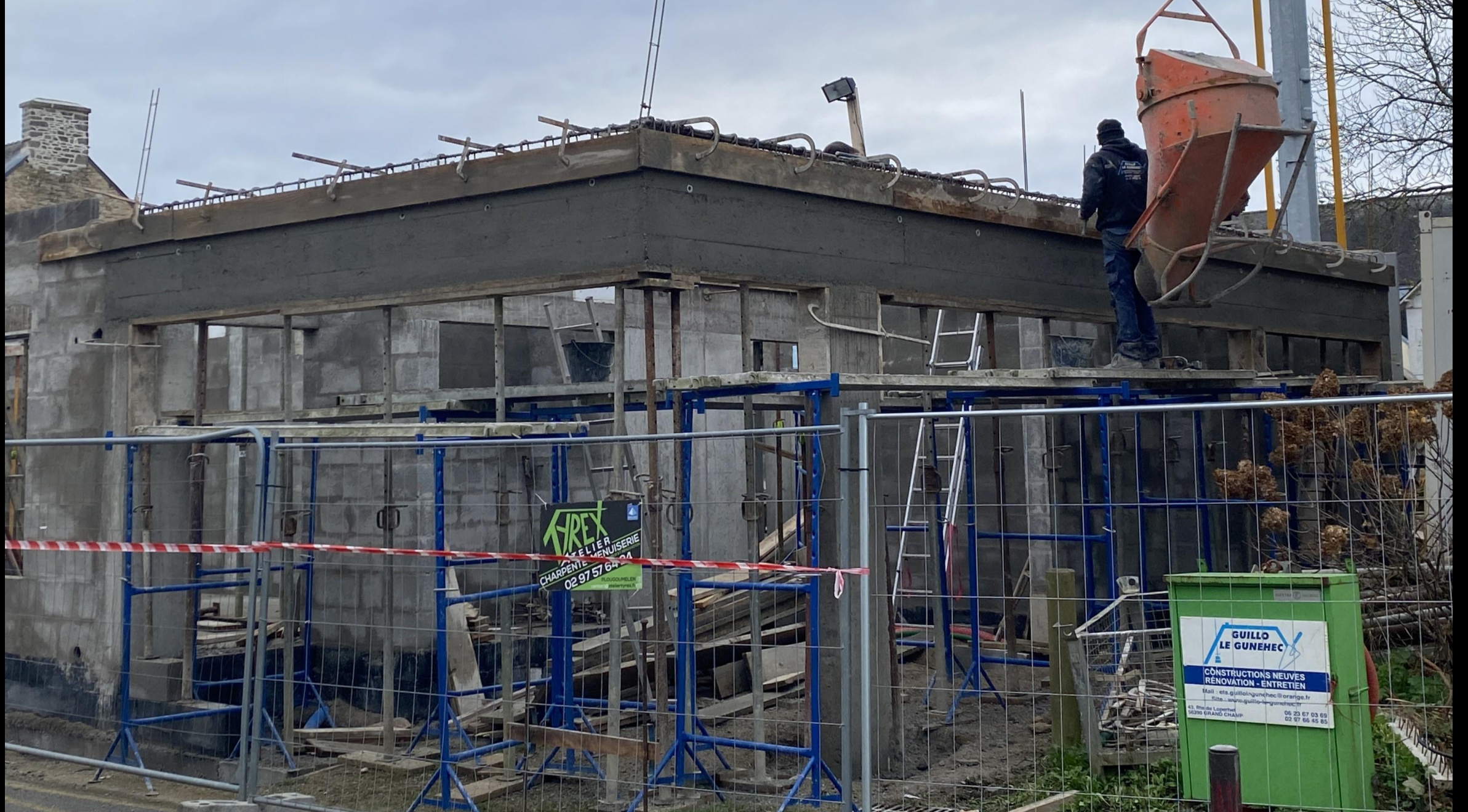
10 décembre 2024 : les poutres sont coulées, et les maçons finalisent les arases avant la pose du plancher.
