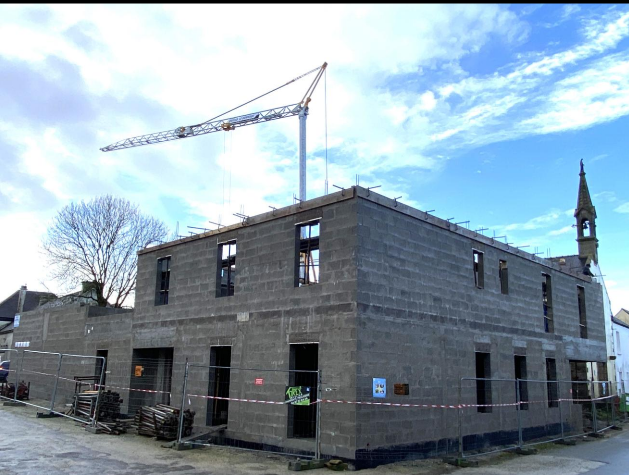
23 janvier 2025 : les maçons ont coffré le sommet des murs du 1 er étage.
