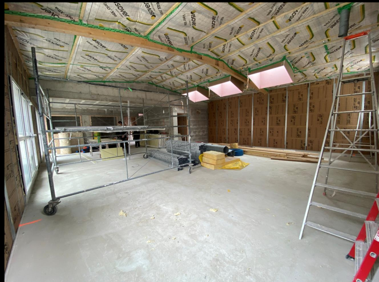
L'isolation du plafond et des murs extérieurs est terminée dans la grande salle de réunion.
