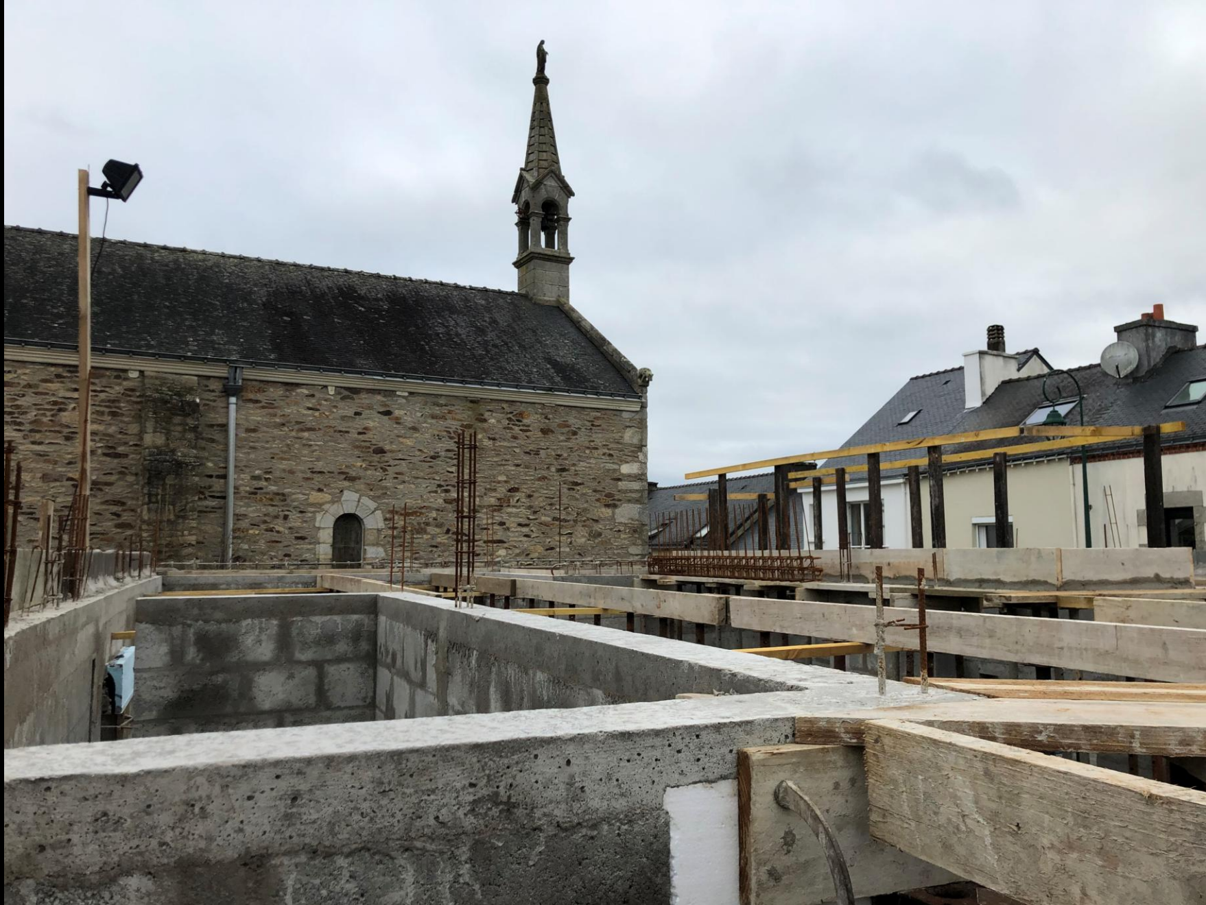
Les arases sont prêtes pour la pose des prédalles de plancher.
