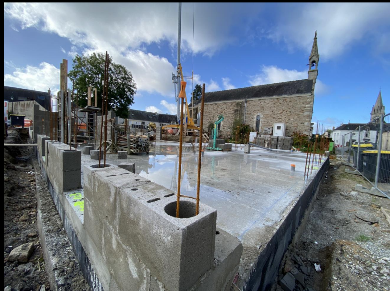
18 octobre 2024 : la base des murs en banché est décoffrée et deux premiers rangs de parpaings sont posés sur la façade Est.
