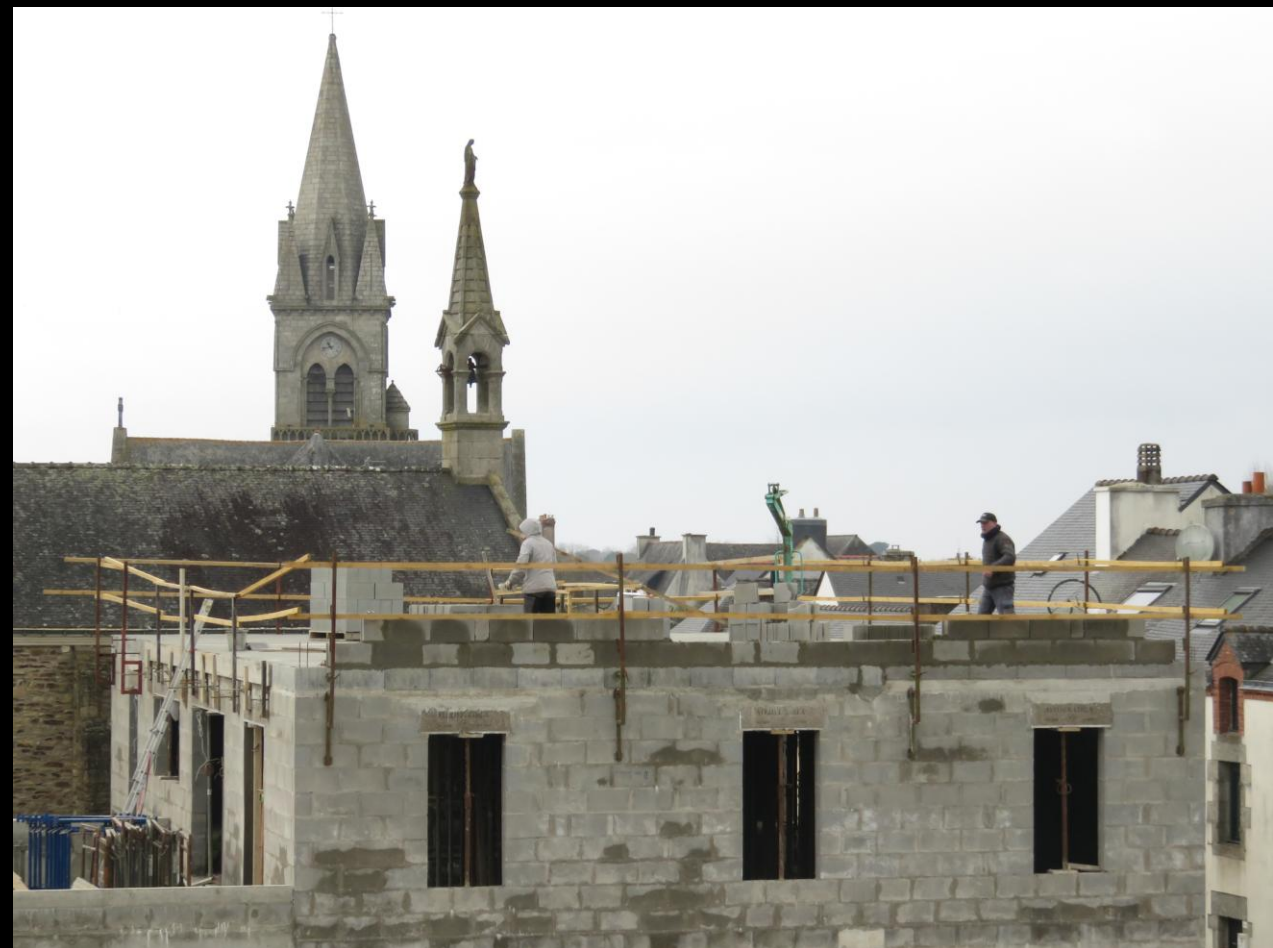
7 février 2025 : la dalle étant coulée, les maçons s'attaquent maintenant à la dernière partie du travail les concernant : le montage des pointes des pignons.
