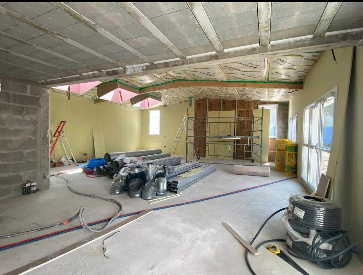
10 juin 2025 : le placo est en grande partie réalisé sur les murs intérieurs de la grande salle de réunion, tandis que le plâtre est en cours d'exécution dans le hall d'entrée de la maison interparoissiale.
