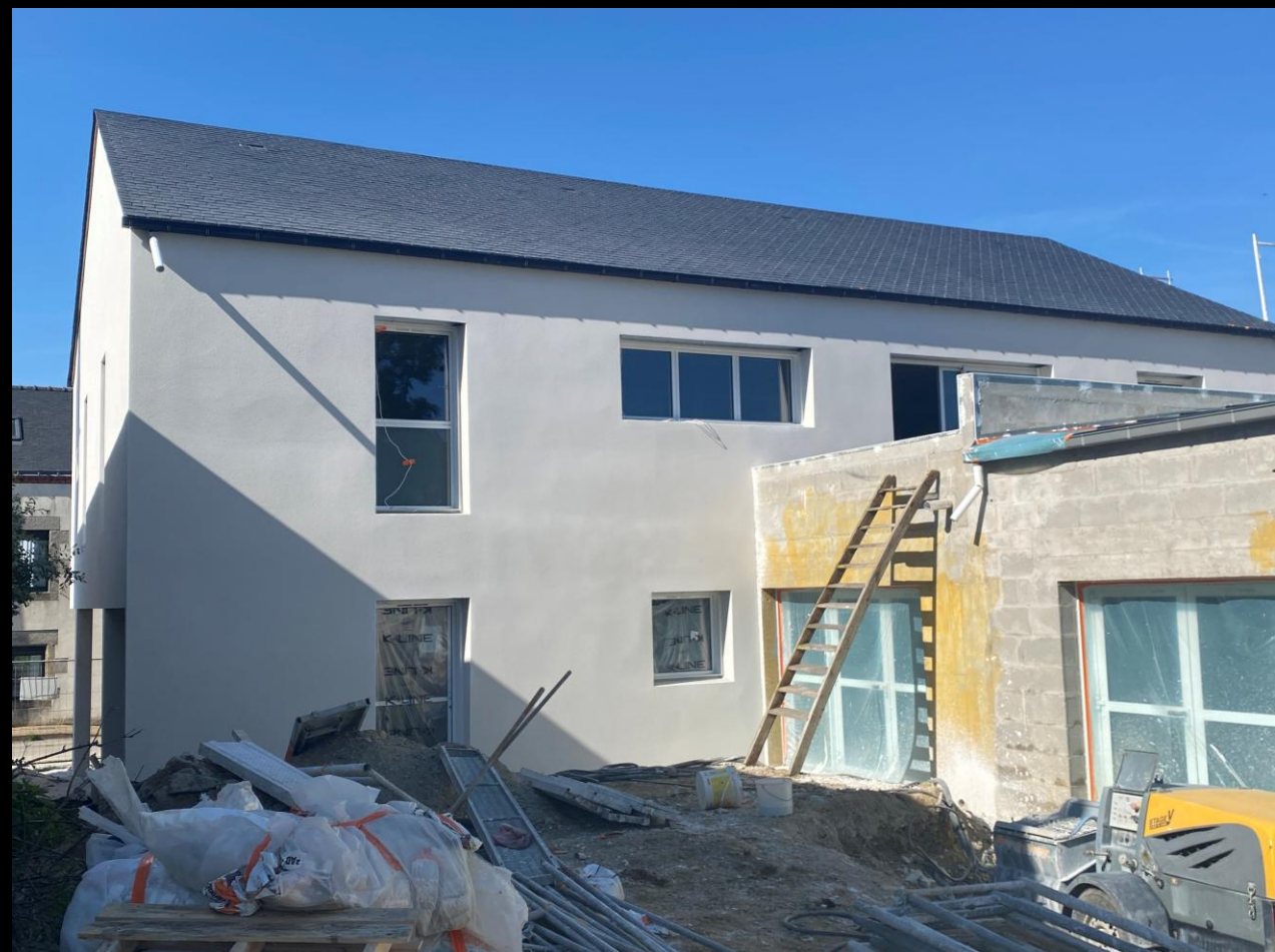
14 mai 2025 : l'enduit réalisé sur 2 premières façades donne un nouvel aspect au bâtiment.
