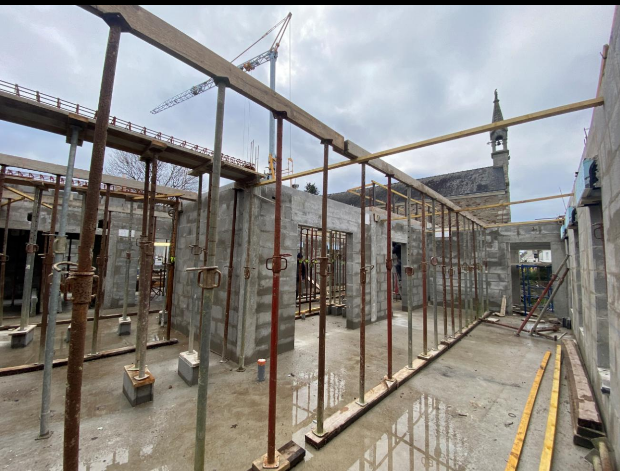
A l'intérieur, les étais sont en place avant la pose imminente du plancher.
