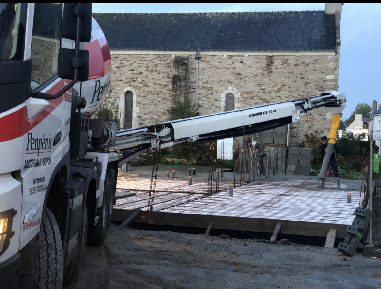
17 octobre 2024 : la toupie est de retour pour déverser son béton sur la dalle.
