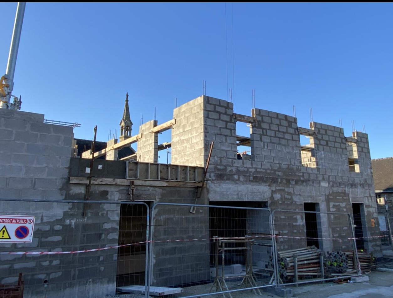
17 janvier 2025 : par un temps froid et sec, les maçons poursuivent le travail avec la préparation de la pose des coffres de volets roulants de l'étage.
