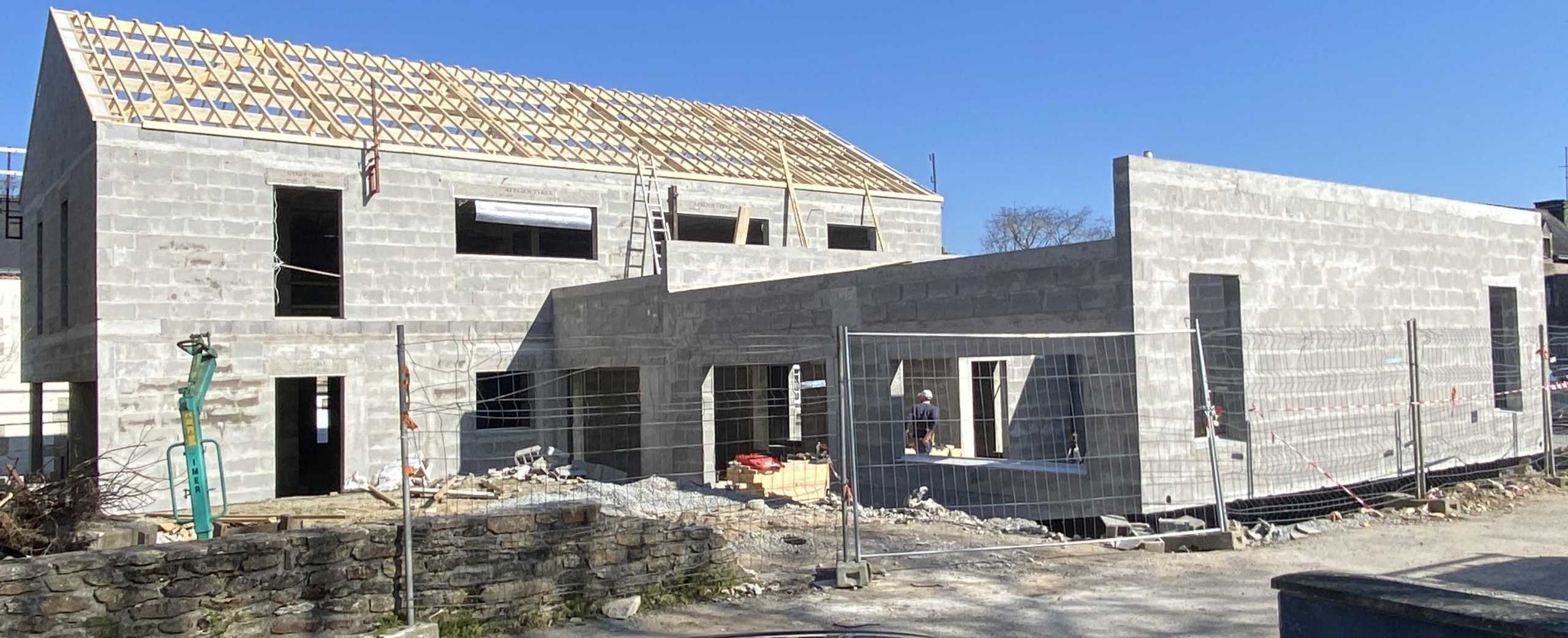
5 mars 2025 : la charpente est quasiment terminée sur le grand bâtiment. Les charpentiers vont pouvoir s'atteler au montage de la deuxième charpente.
