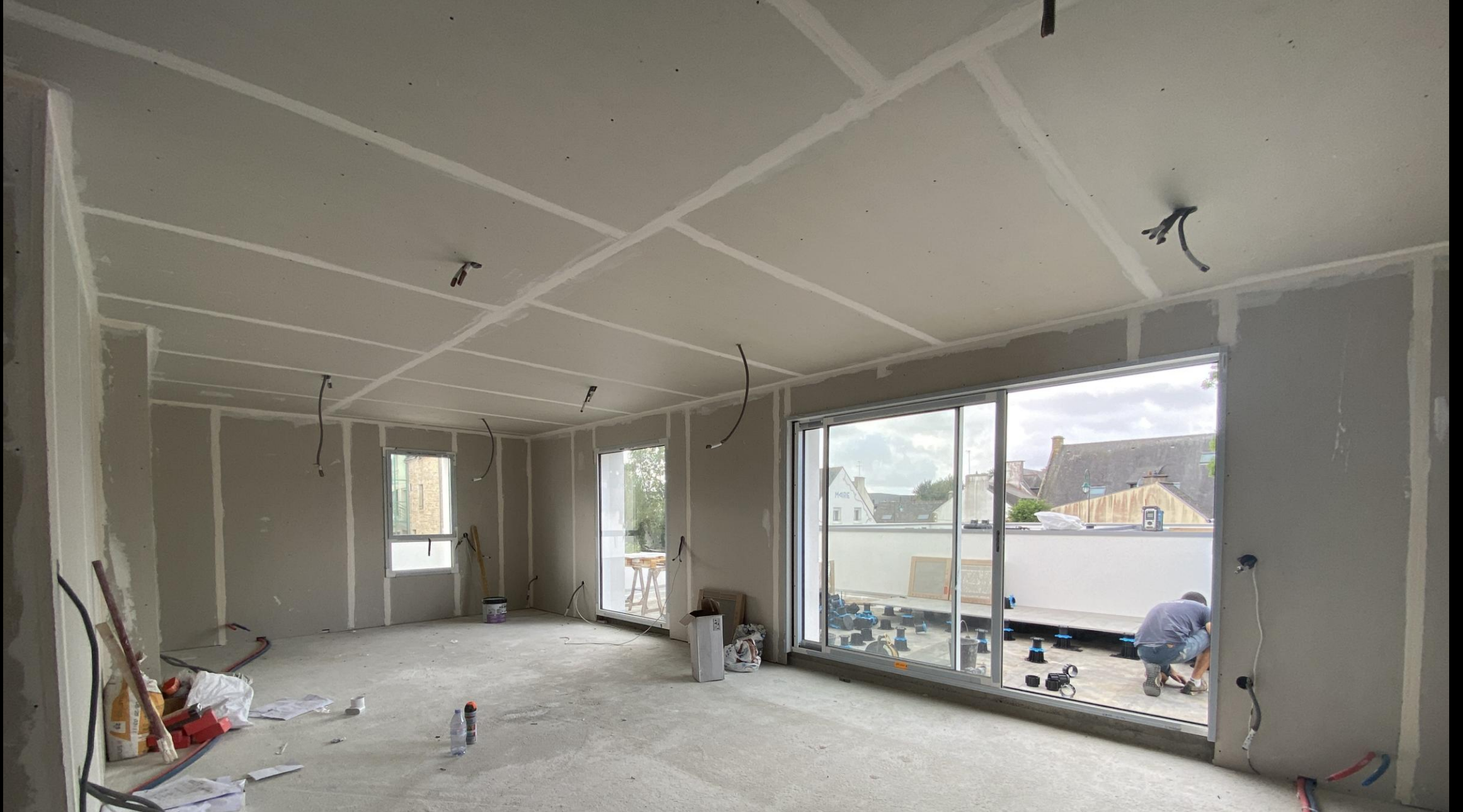
A l'étage, le plafond en placo est terminé. A l'extérieur, le carreleur place les plots qui recevront les dalles pour couvrir la terrasse.
