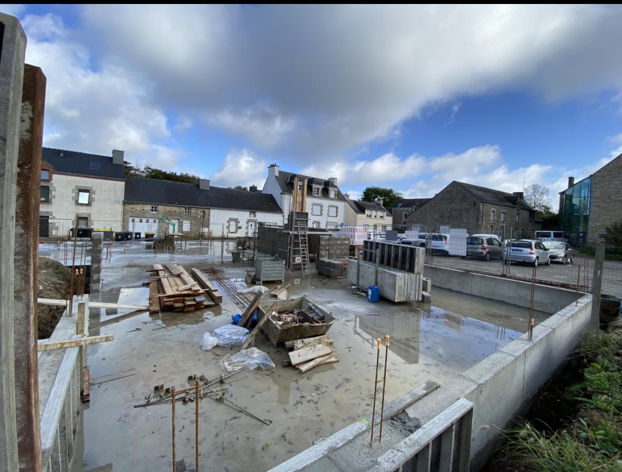
18 octobre 2024 : la base des murs en banché est décoffrée et deux premiers rangs de parpaings sont posés sur la façade Est.
