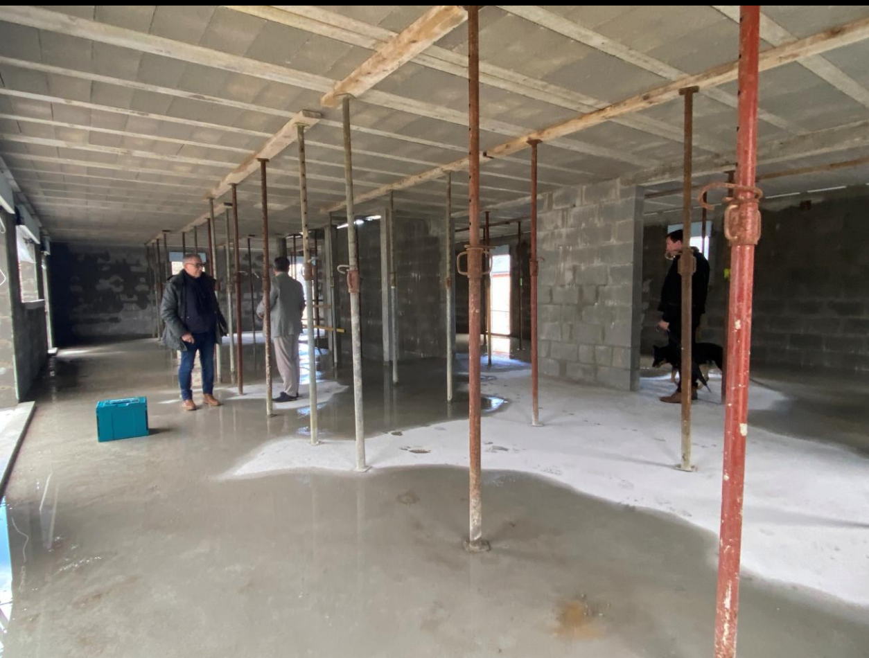
A l'étage, quelques étais soutiennent encore le plancher en béton.
