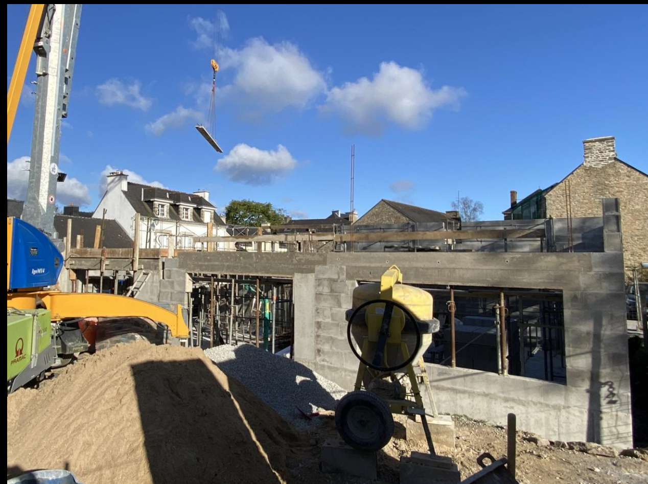
Côté Ouest, une rampe de chantier permet d'entrer dans le bâtiment par la future porte d'accès à l'habitation des prêtres. Les poutres au-dessus des baies de la grande salle de réunion sont décoffrées.
