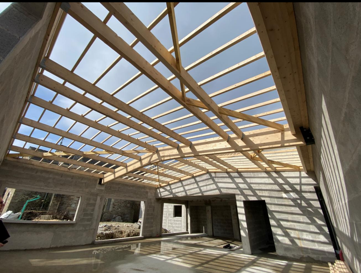
7 mars 2025 : la charpente de la grande salle de réunion est terminée. Le couvreur va pouvoir intervenir dans une quinzaine jours pour la pose de la toiture.
