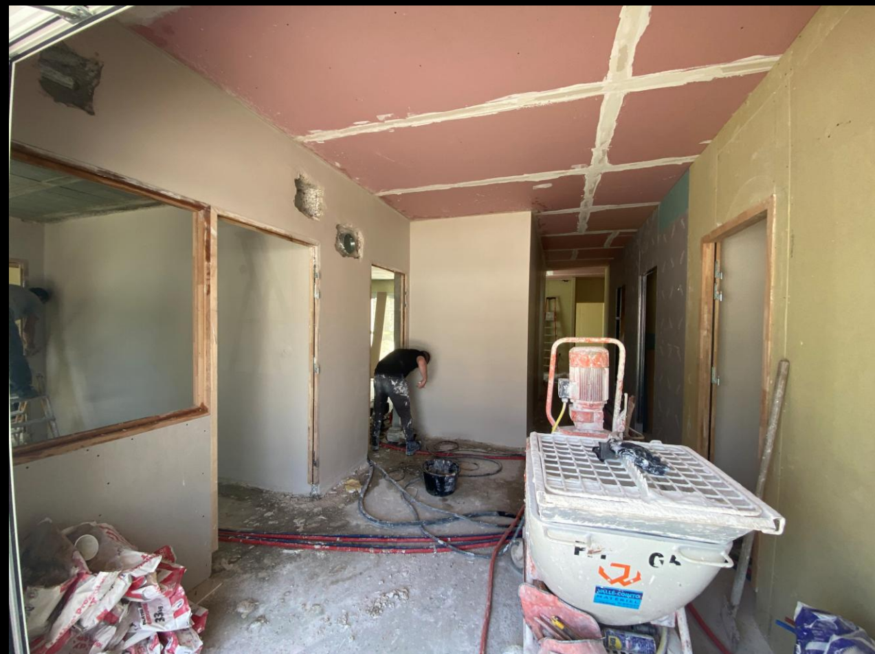
10 juin 2025 : le placo est en grande partie réalisé sur les murs intérieurs de la grande salle de réunion, tandis que le plâtre est en cours d'exécution dans le hall d'entrée de la maison interparoissiale.
