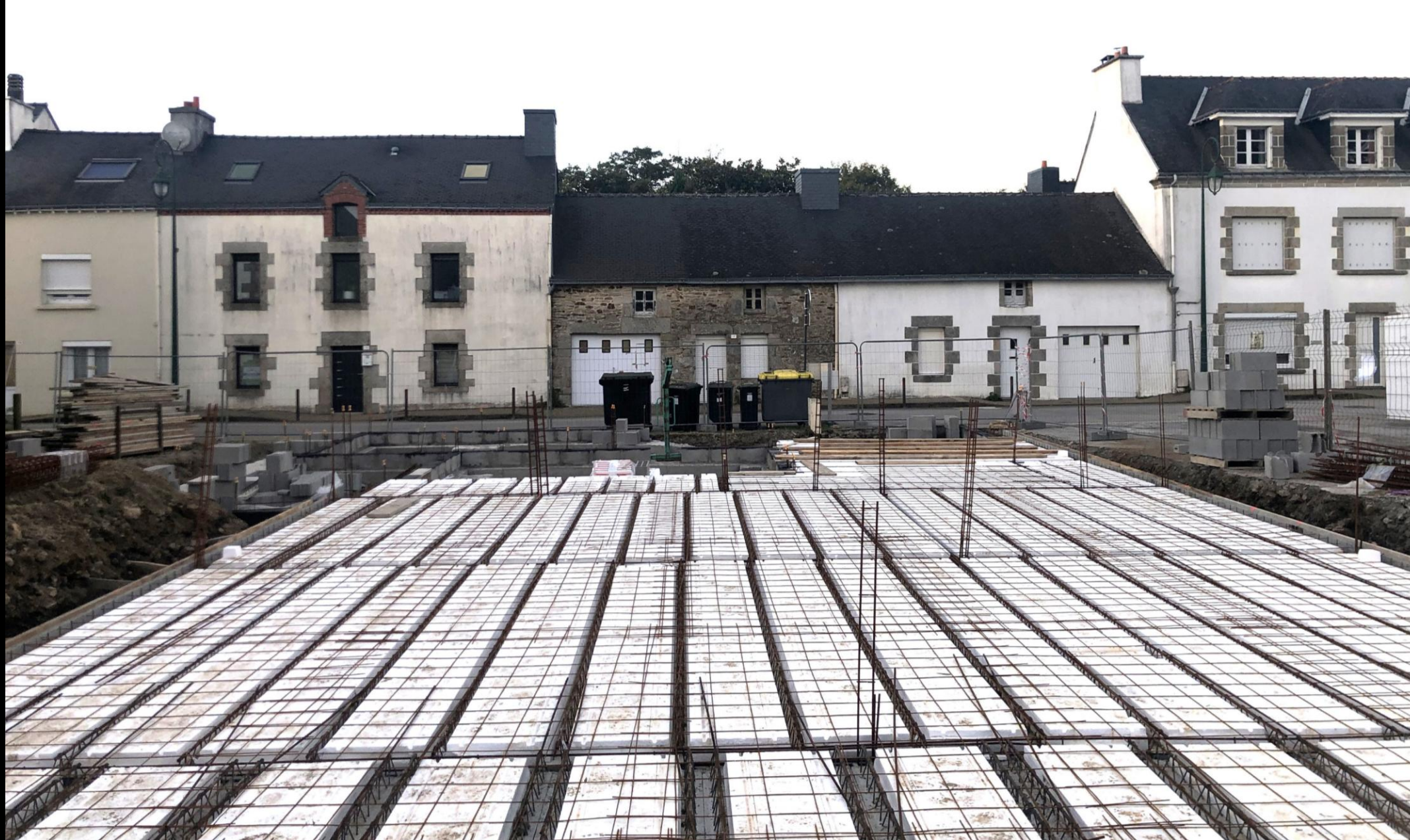
27 septembre 2024 : il faut ferrailer le plancher avant de couler le béton.
