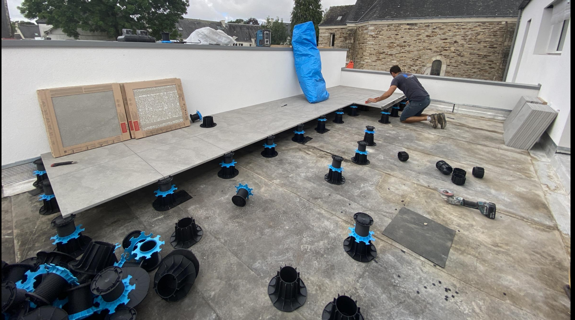
Les premiers carreaux de carrelage sont en place sur la terrasse.
