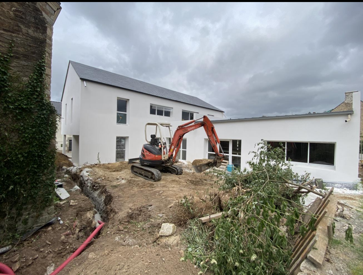
3 juin 2025 : La pelleteuse est en action pour dégager la cour intérieure des gravats qui l'encombrent et aussi pour réaliser les remblaiements périphériques.
