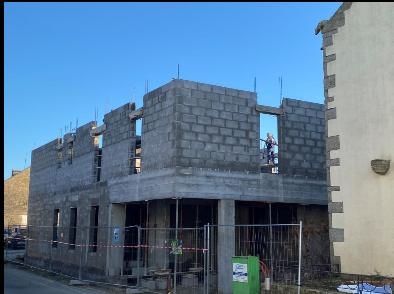
17 janvier 2025 : par un temps froid et sec, les maçons poursuivent le travail avec la préparation de la pose des coffres de volets roulants de l'étage.
