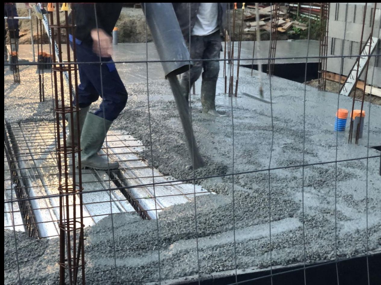
17 octobre 2024 : la toupie est de retour pour déverser son béton sur la dalle.
