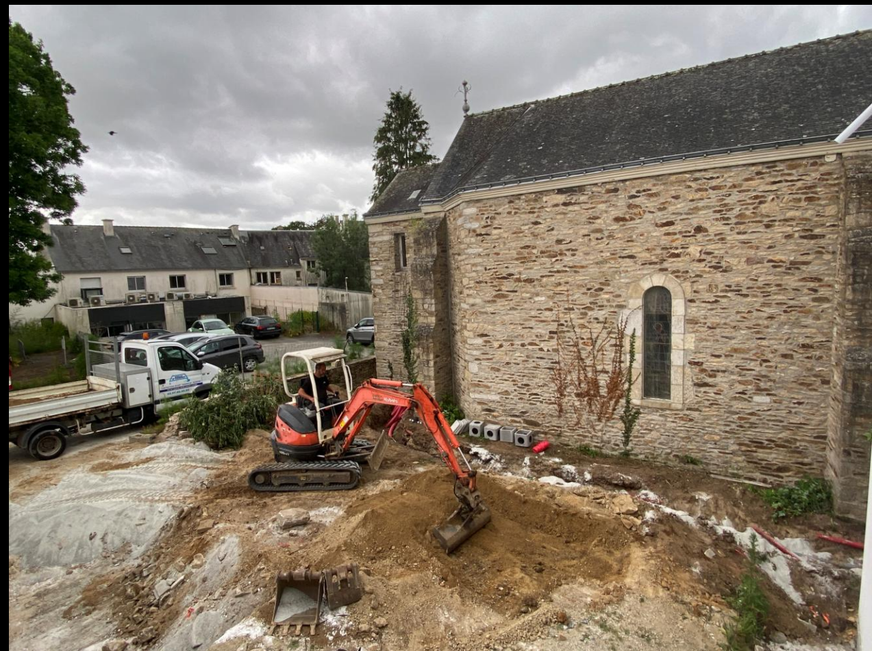
3 juin 2025 : La pelleteuse est en action pour dégager la cour intérieure des gravats qui l'encombrent et aussi pour réaliser les remblaiements périphériques.
