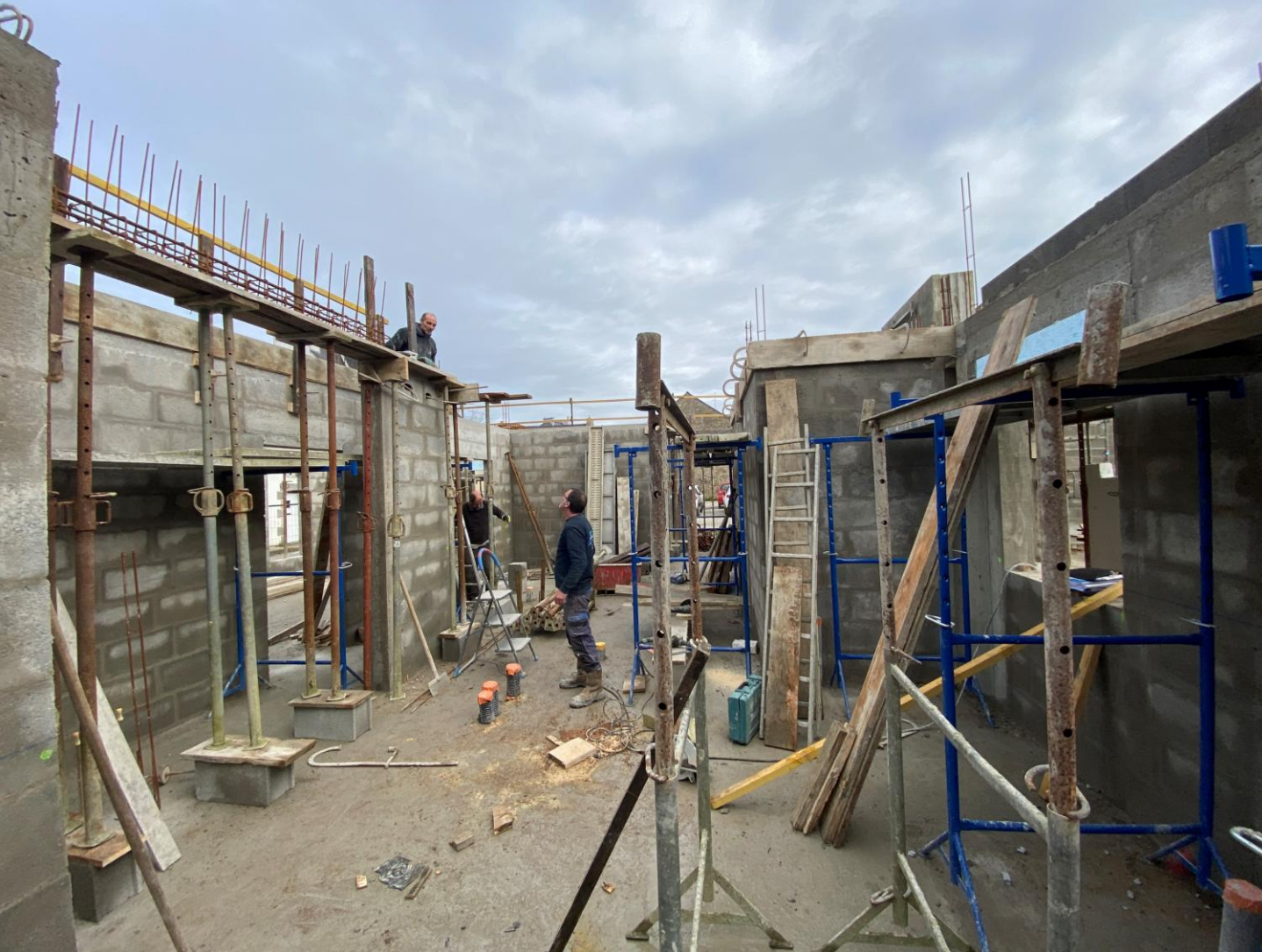
3 décembre 2024 : les maçons préparent les poutres qui supporteront le plancher haut RDC.
