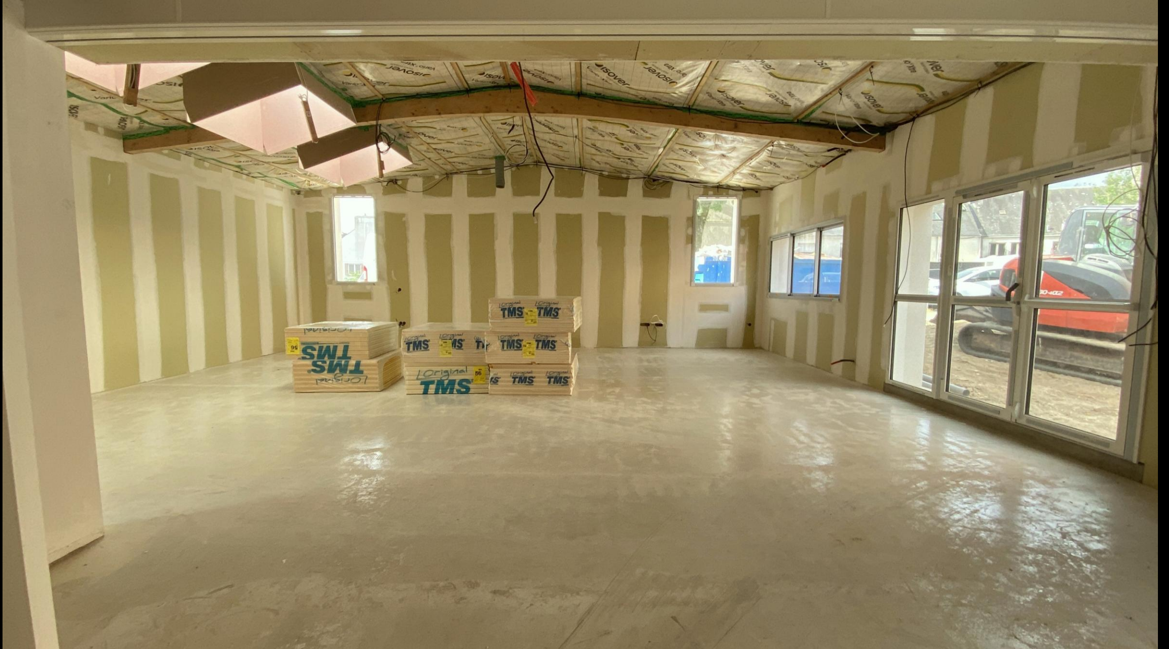
15 juillet 2025 : la préchape a été coulée sur la totalité du rez-de-chaussée, avant la pose d'un isolant et la réalisation de la chape dans quelques jours.
