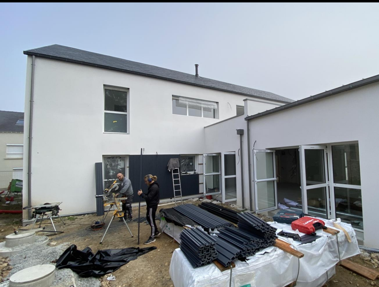
30 septembre : la pose du bardage extérieur a démarré. Nous pouvons ainsi découvrir progressivement l'aspect extérieur final de la maison interparoissiale.
