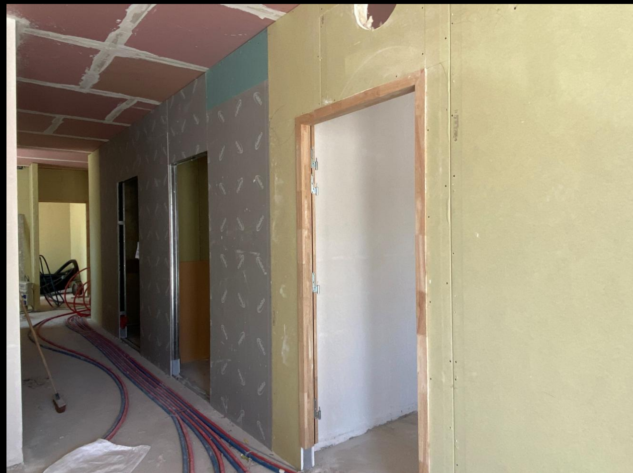
17 juin 2025 : le placo et le plâtre sont terminés au rez-de-chaussée.
