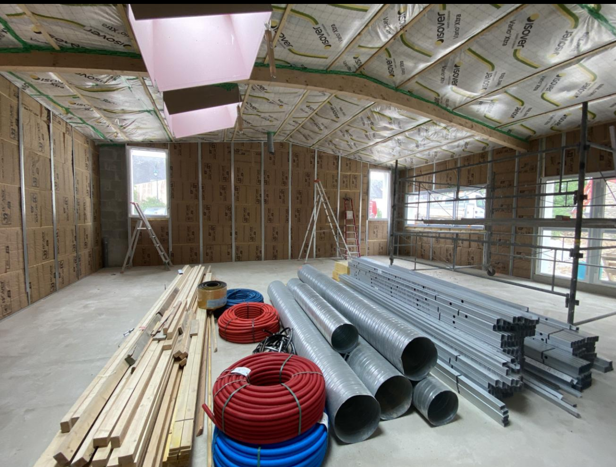
L'isolation du plafond et des murs extérieurs est terminée dans la grande salle de réunion.
