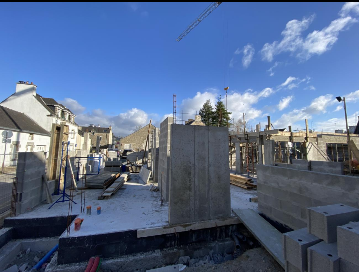
Côté Ouest, une rampe de chantier permet d'entrer dans le bâtiment par la future porte d'accès à l'habitation des prêtres. Les poutres au-dessus des baies de la grande salle de réunion sont décoffrées.
