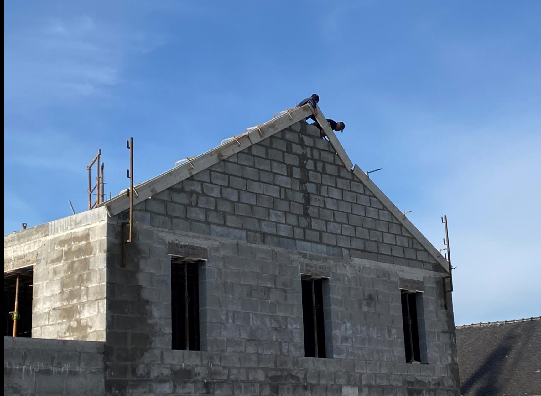
11 février 2025 : les maçons terminent de monter la pointe de pignon Ouest, et finalisent le coffrage du pignon Est avant de couler le béton de rampanage.
