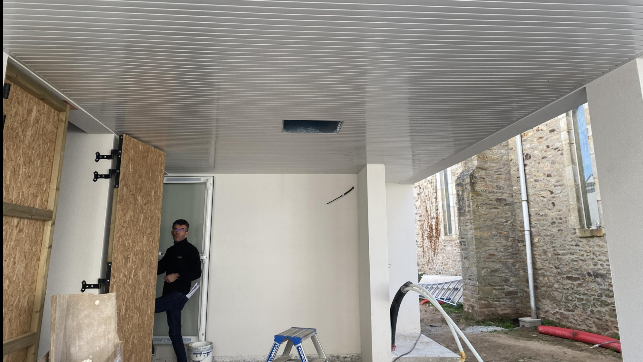
A l'extérieur, un lambris a été posé au niveau du garage.
