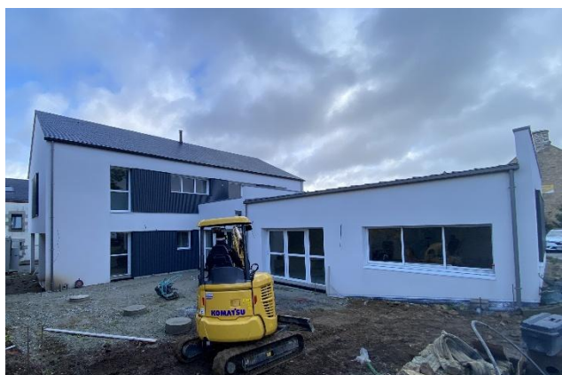
Avec sa mini-pelleteuse, le paysagiste procède à l'aménagement de la cour intérieure.
